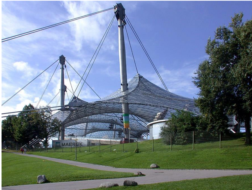
Obrázek 1.14.: Zavěšená střešní konstrukce, Olympijský stadion Mnichov [22]
