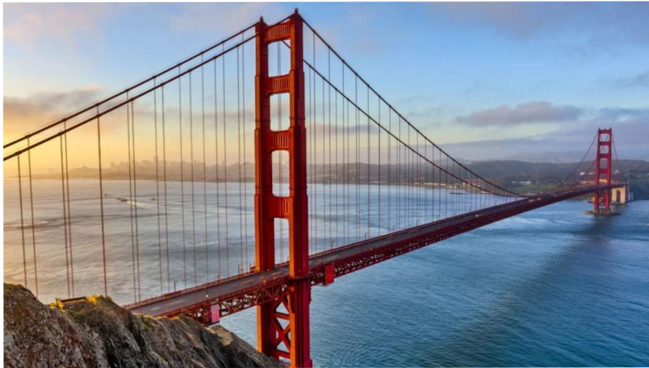
Obrázek 2.3: Tvar parabolické řetězovky v praxi – Golden Gate Bridge [25]
