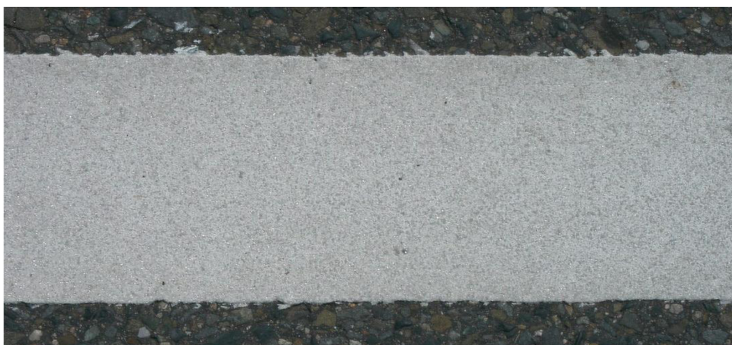
Obr. 1 – Příklad VDZ s hladkým povrchem
