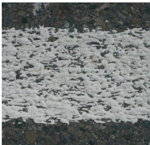
Obr. 2 – Příklad strukturálního VDZ
