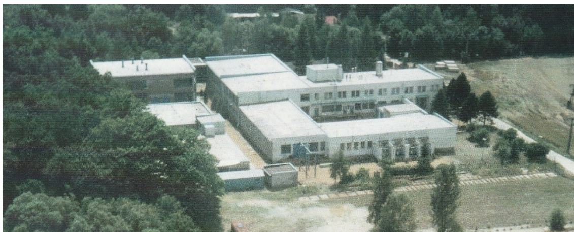
Obr 2.1.2 Úpravna vody Troubky. Zdroj: ÚV Troubky
