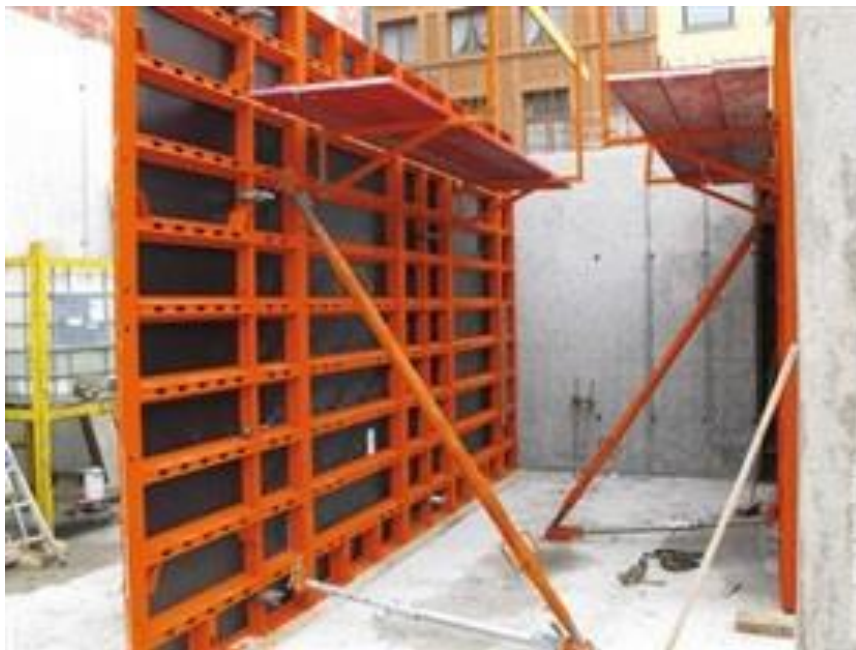
Obrázek 73 - Systémové bednění pro stěny s lávkou [55]
