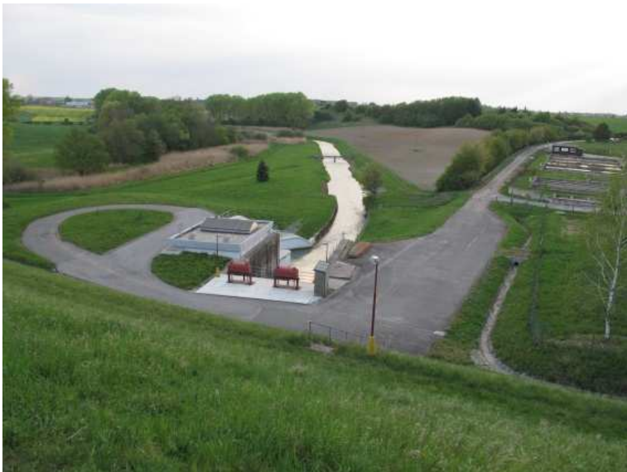
Příloha 9: Pohled do údolí pod VD Rozkoš (zdroj vlastní):
