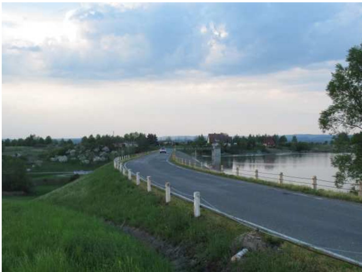
Příloha 10: Hráz VD Rozkoš (vlastní zdroj):
