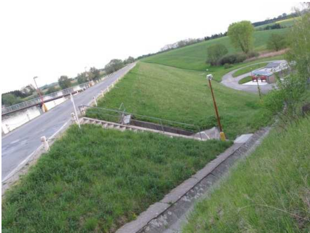
Příloha 8: Vchod do kontrolní chodby na vodním díle Rozkoš (vlastní zdroj):
