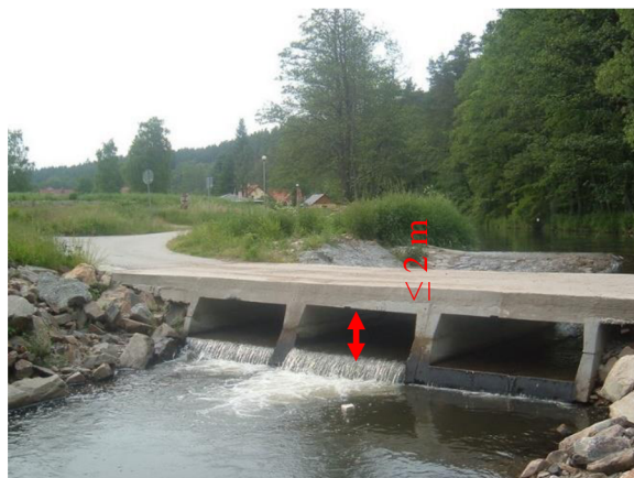
Obr. 2. Betonový propustek [17]
