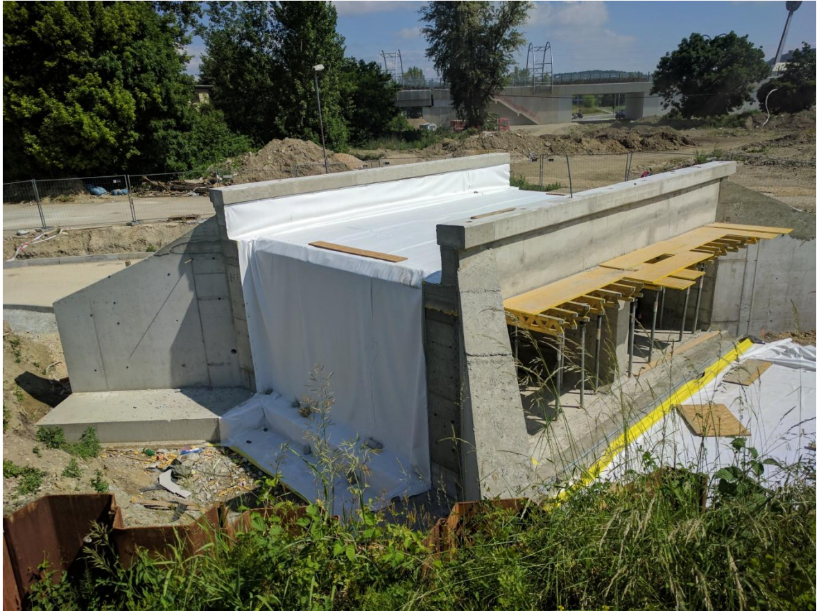
Obrázok 7-17: Podchod po betonáži dilatačných celkov [autor]
