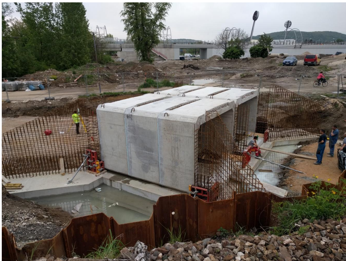
Obrázok 7-13: Osadené rámové prefabrikáty tubusov [autor]
