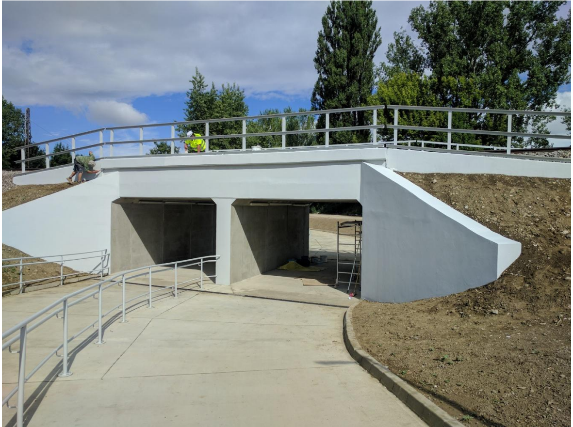
Obrázok 3-4: Podchod pod železničnou traťou, smer Trenčín Zlatovce [autor]
