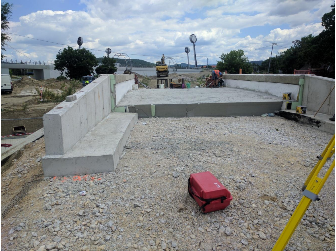
Obrázok 7-20: Rímsová stienka po realizácii [autor]
