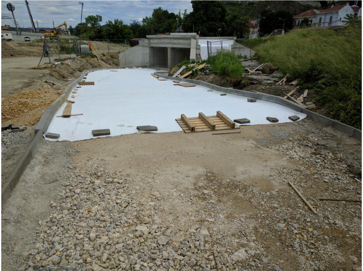
Obrázok 7-16: Osadené obrubníky komunikácie podchodu [autor]
