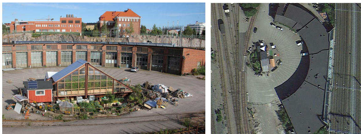
OBR. 58: pohľad na objekt Turntable (vľavo), umiestnenie medzi koľajiskami (vpravo)
