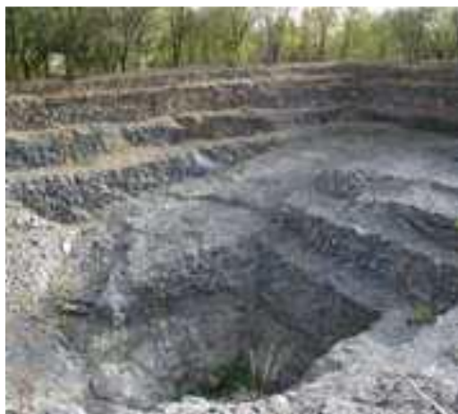
Obrázek 6: Budování otevřené šachty pro infiltraci povrchové vody v Radžastánu v Indii (Gale, 2005)
