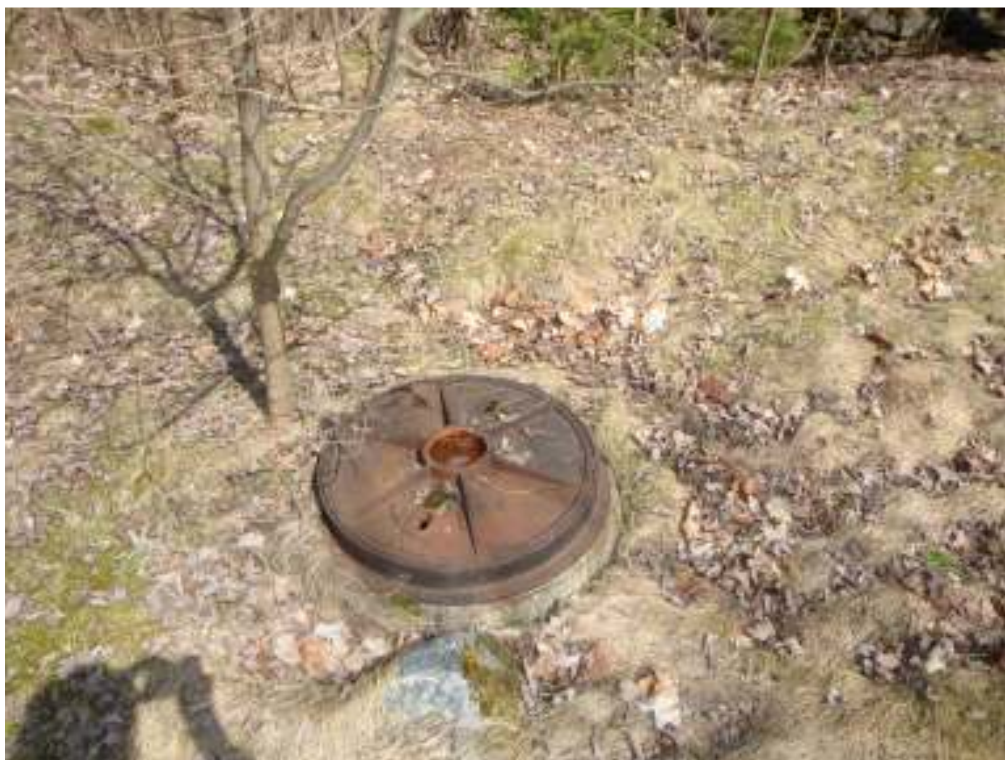
Foto č. 4: Kanalizace
