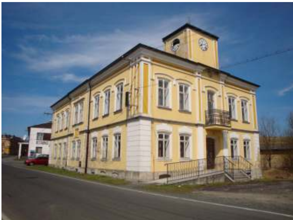
Foto č. 6: Budova bývalé radnice
