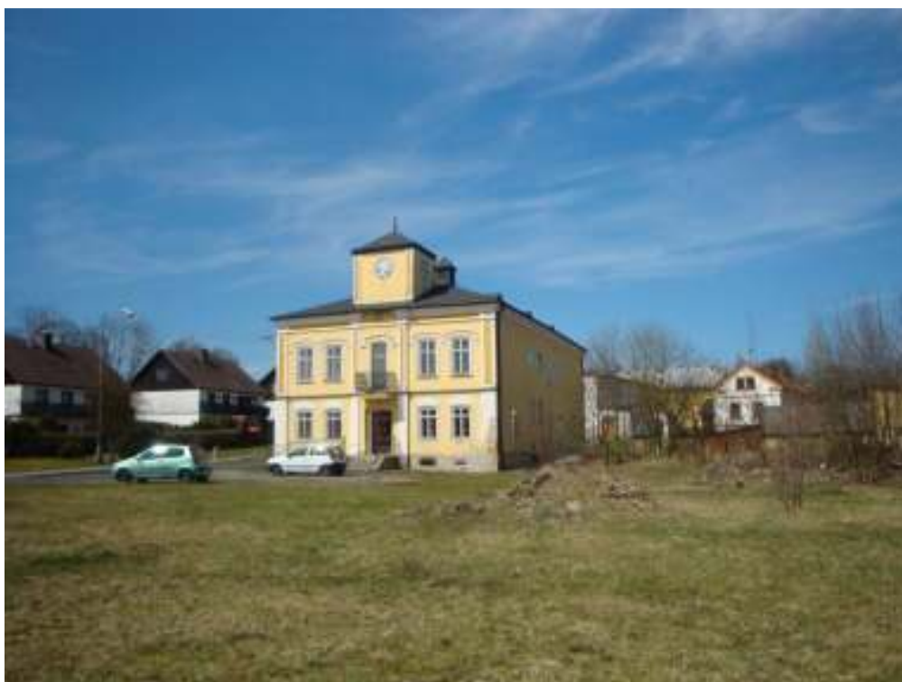
Foto č. 3: Budova bývalé radnice
