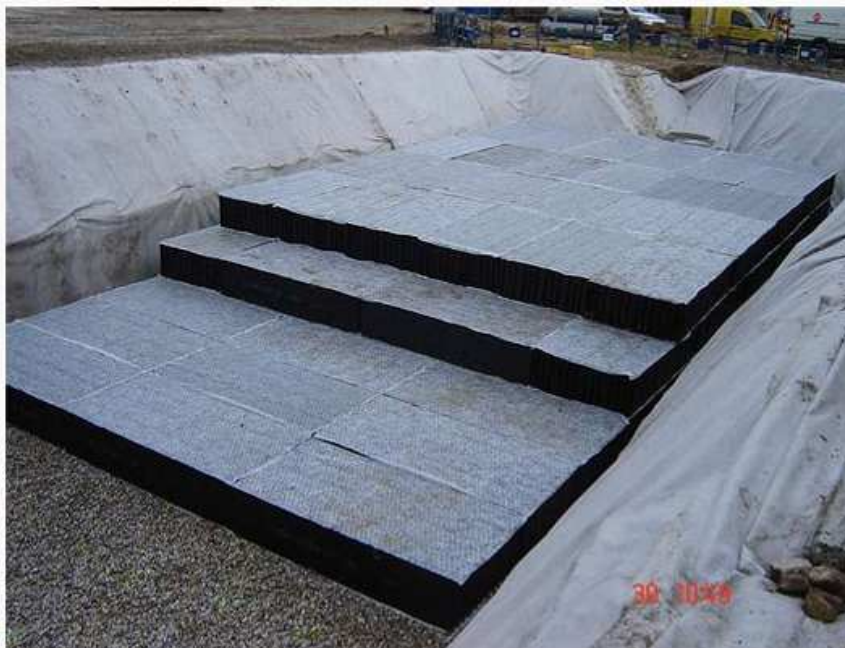
Obr. č. 28 – Voštinové bloky, tvořící vsakovací objekt [33]
