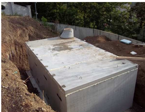
Obr. č. 13- Betonová prefabrikovaná pravoúhlá nádrž [16]
