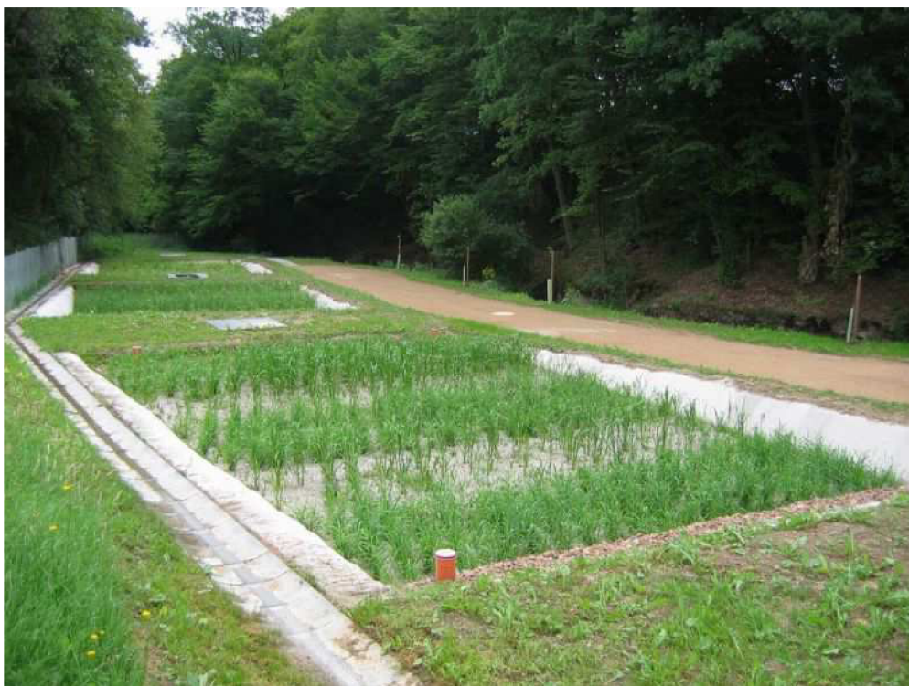
Obr. č. 27 - Kořenová čistírna odpadních vod [30]
