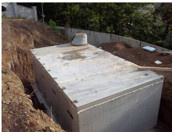
Obr. č. 13- Betonová prefabrikovaná pravoúhlá nádrž [16]
