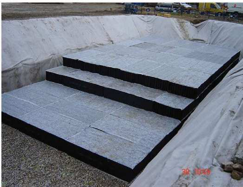
Obr. č. 28 – Voštinové bloky, tvořící vsakovací objekt [33]
