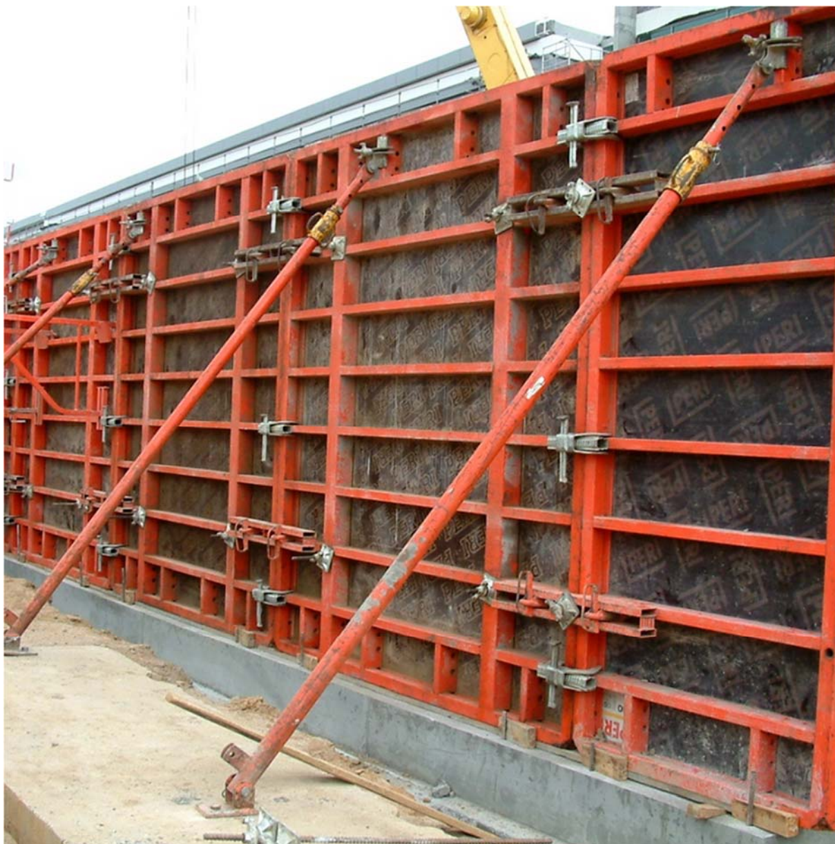
Obr. 53: Bednění PERI + podepření
