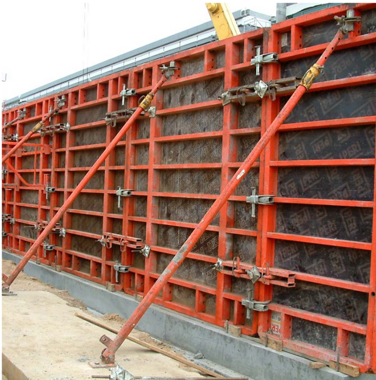
Obr. 53: Bednění PERI + podepření
