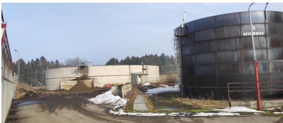
Obr. 4.7 Mechanický separátor a skladovací nádrže fugátu; zdroj: fotografie autora
