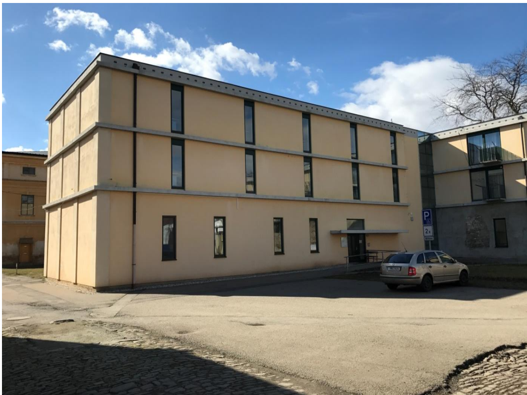
Foto 56: Zámek Výšovice – nové bytové prostory – zadní část
