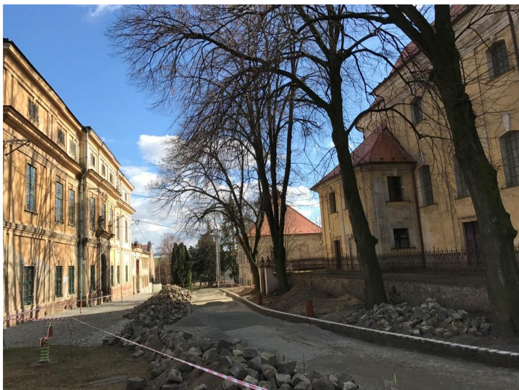
Foto 51: Zámek Výšovice – rekonstrukce silnice
