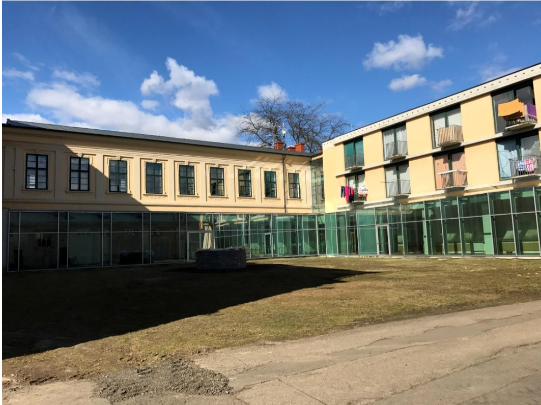
Foto 55: Zámek Výšovice – budova HANDICAP
