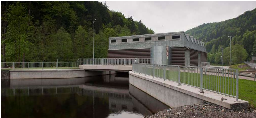
Obr. č. 10. –Beztlaký vtokový objekt na MVE Železný Brod, řeka Jizera ( http://www.stavbaroku.cz/printDetail.do?Dispatch=ShowDetail&siid=672&coid=2 )
