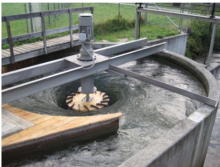
Obr. č. 16. – Příklad realizace vírové turbíny v rakouském Ober-Grafendorfu
