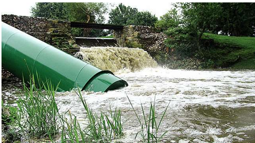
Obr. č. 28. – Příklad instalace trubního provedení Archimédovy turbíny ( http://www.potenergy.co.uk/alhampton_mill.php )
