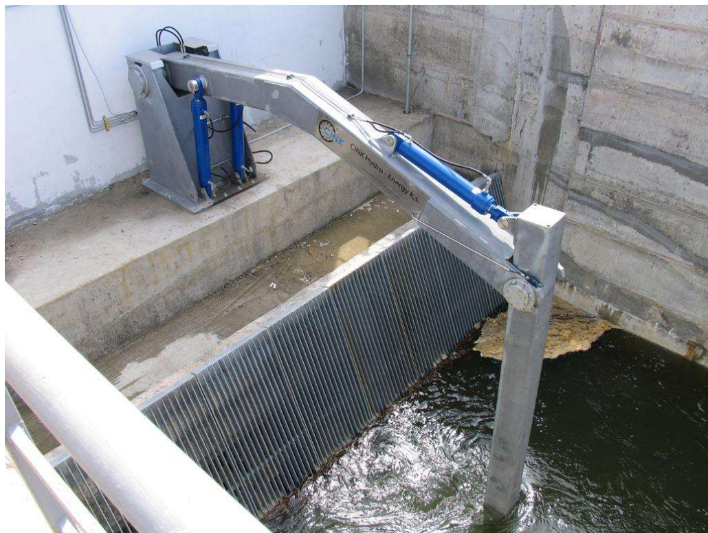
Obr. č. 11. – Příklad instalace jemných česlí s automatickým čištěním
