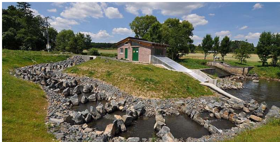
Obr. č. 37. – Dokončená MVE Semošice včetně rybiho přechodu a zakrytování turbíny ( http://www.cht.cz/aktuality/mve-semosice-z-ptaci-perspektivy/ )
