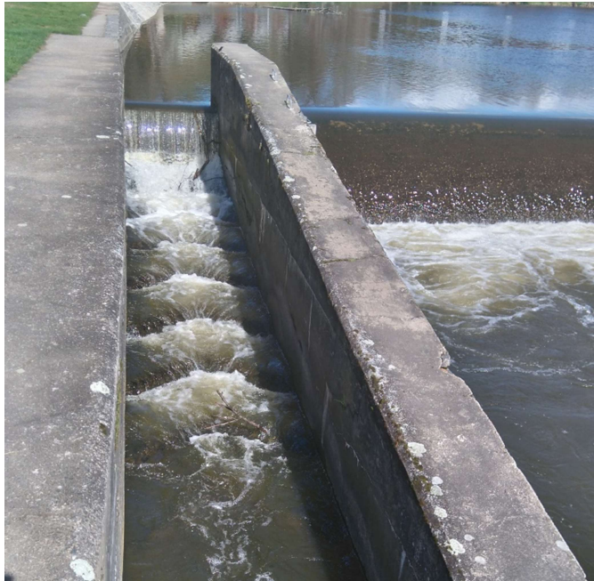
Obr. č. 52. – Sportovní propust' (vlastní fotografie)
