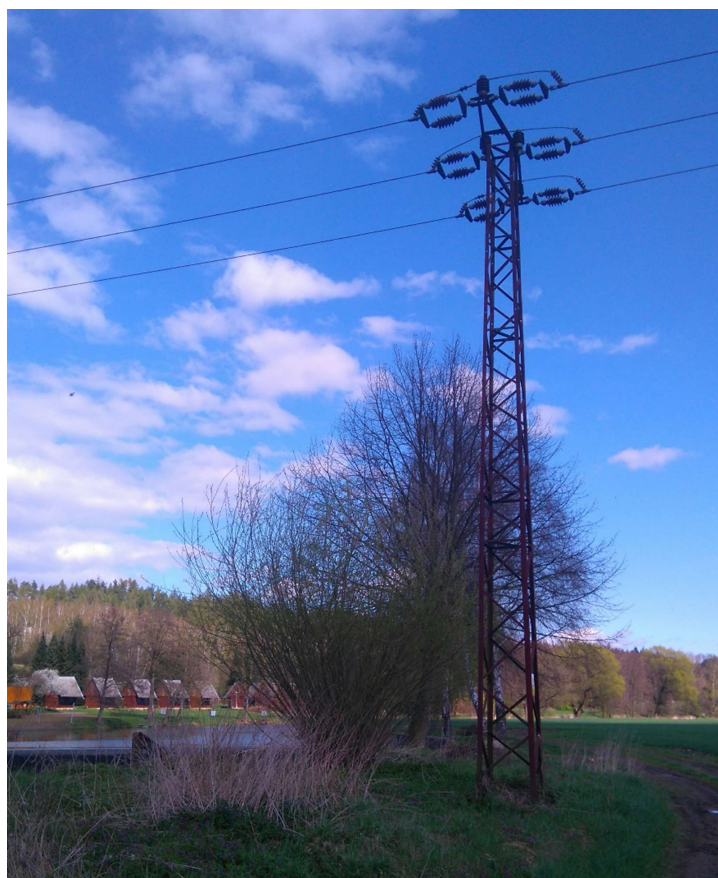
Obr. č. 45. – Pohled na stávající sloup VN 3x22kV (vlastní fotografie)
