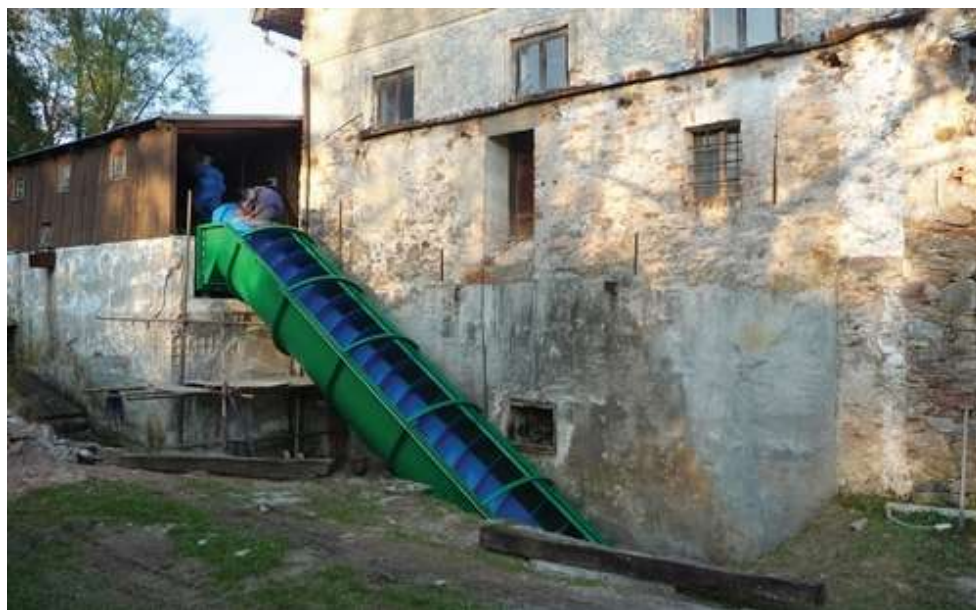
Obr. č. 36. – Instalace turbíny na MVE Červený potok, první realizace v České republice ( http://www.calla.cz/atlas/detail.php?kat=1&id=1993 )
