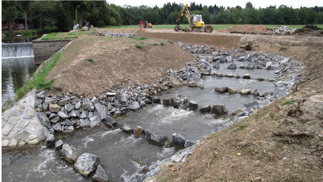
Obr. č. 8. - Rybí přechod v Radobyčicích na řece Úhlavě ( http://www.casopis.forumochranyprrody.cz/magazin/analyzy-komentare/kudy-vede-cesta-zamysleni-nad-fragmentaci-nasich-rek )
