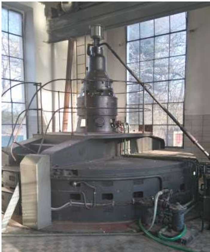
Obr. č. 14. – Hydrostatický generátor na MVE Vršovice na řece Ohři, (vlastní fotografie)
