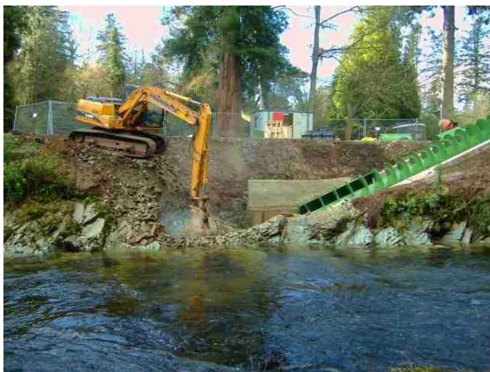
Obr. č. 23. – Stavba malé vodní elektrárny v Dartmoor National Park ( http://www.emersonindustrial.com/enUS/controltechniques/newsandevents/presscenter/pressreleases/Pages/ArchimedesScrewPowersRiverDartCountryPark.asp )
