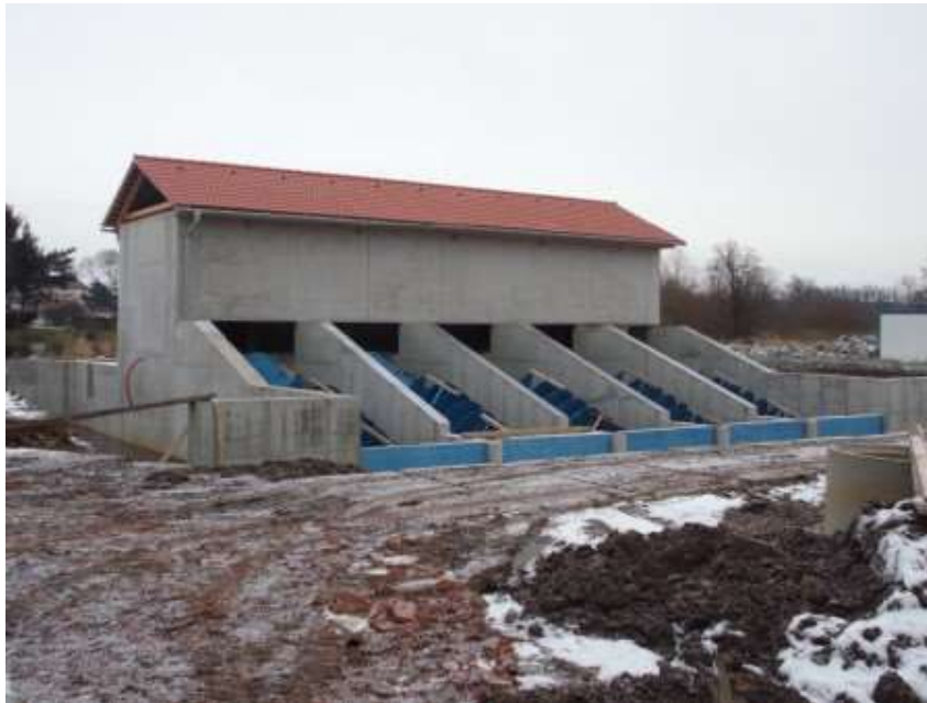
Obr. č. 34. – Stavba MVE Soběslav
