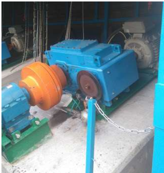
Obr. č. 33. – Pohled na složení horního ložiska, spojky, převodové skříně a asynchronního generátoru na MVE Kaceřovský mlýn (vlastní fotografie)
