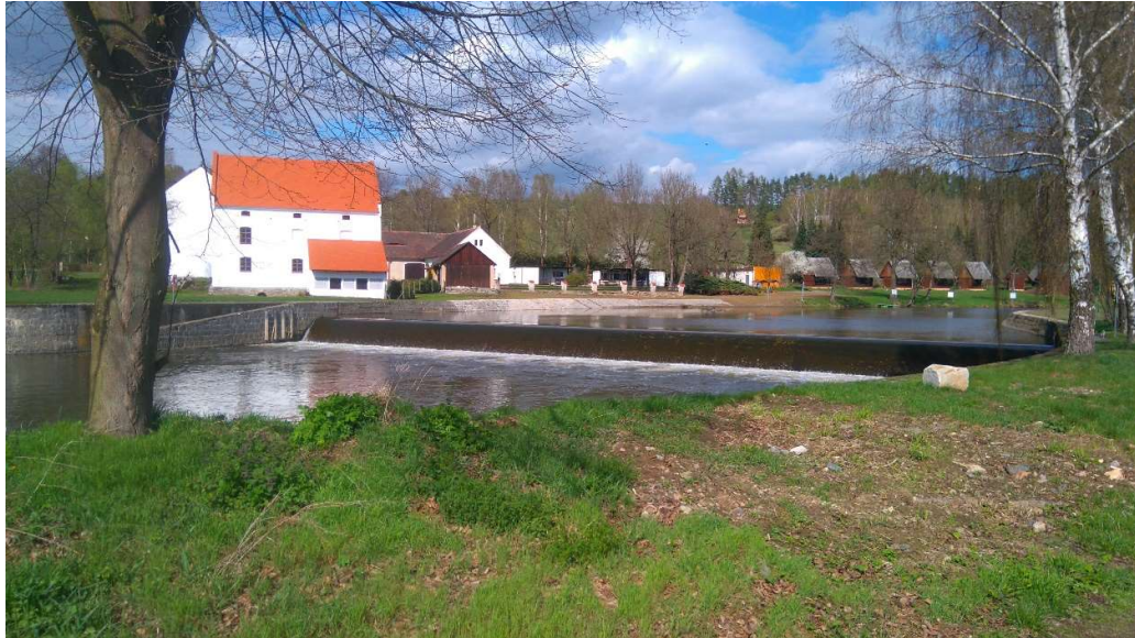
Obr. č. 42. – Pohled na stávající jezovou stavbu (vlastní fotografie)
