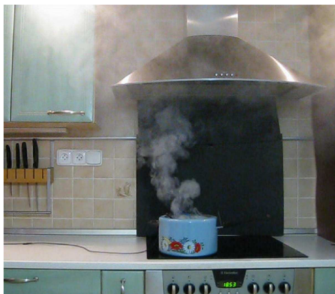
Obr. 11 Vývin páry bez sepnutého odsávání - čelní pohled
