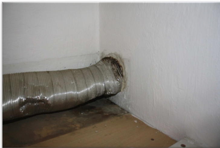
Obr. 22 Původní stav prostupu potrubí
