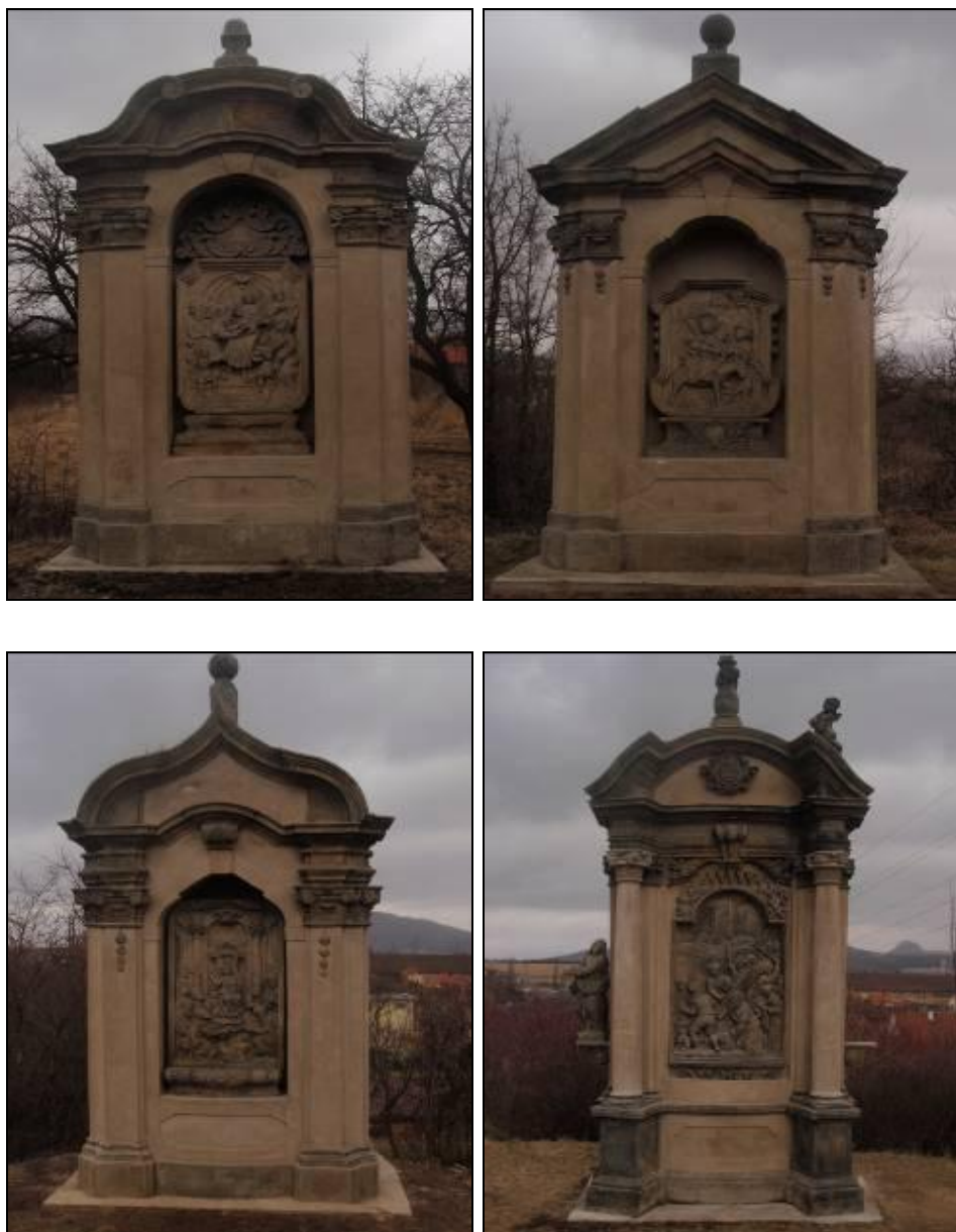
Výklenkové kaple I – IV po restaurování v roce 2012
