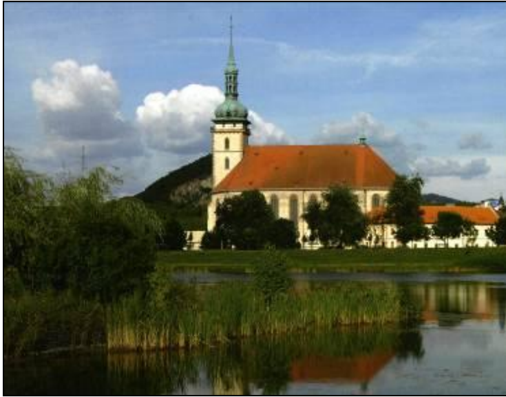
Kostel v novém prostředí po přesunu, rok 2010
