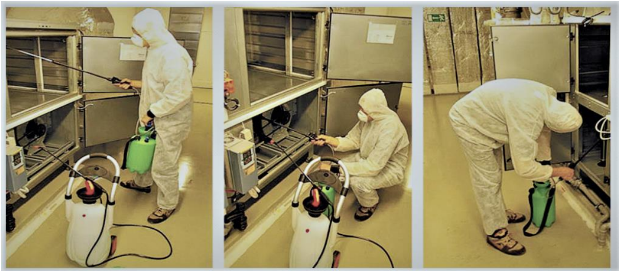
Obr. 10 Chemické čištění VZT jednotky [24]
