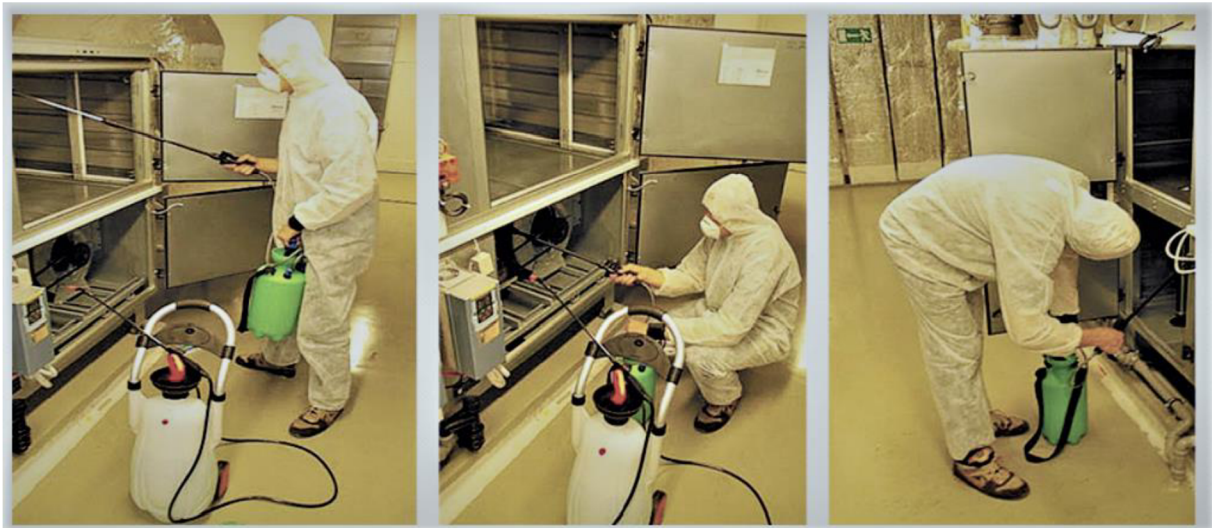
Obr. 10 Chemické čištění VZT jednotky [24]
