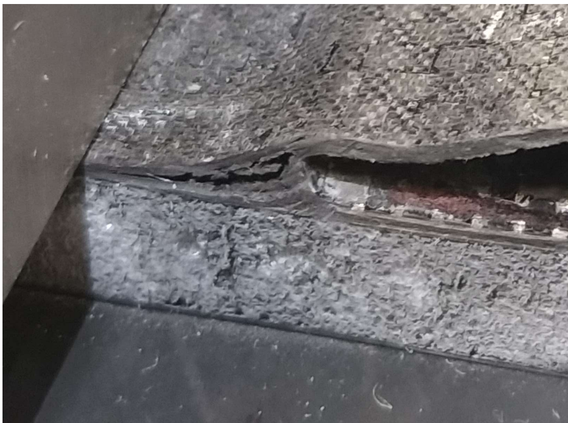
Obrázek 10.5: Detail delaminace mezi spodním a středním skinem.
