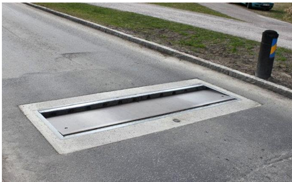
Obr. 8: Aktivní zpomalovací práh
