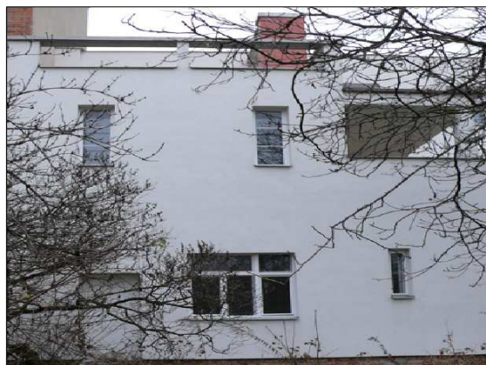
Obr. 3.4: Zadní fasáda po rekonstrukci [30]
