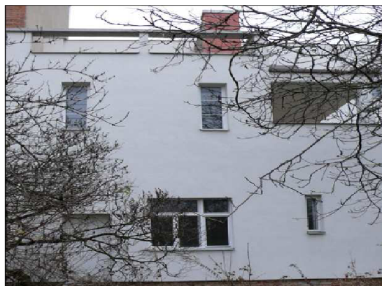
Obr. 3.4: Zadní fasáda po rekonstrukci [30]
