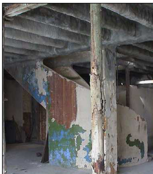
Obr. 3.10: Hlavní schodiště v roce 2007 [30]
