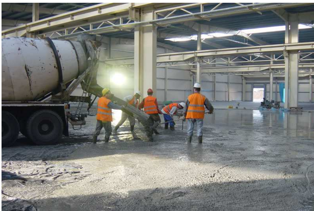
Obr. 7.6a. Ukládání betonu pomocí skluzu
