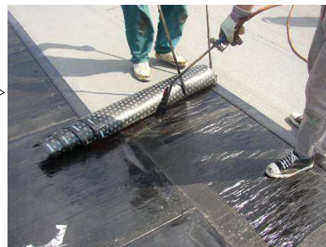
obr.7.1.3b. Natavování hydroizolačních pásů
