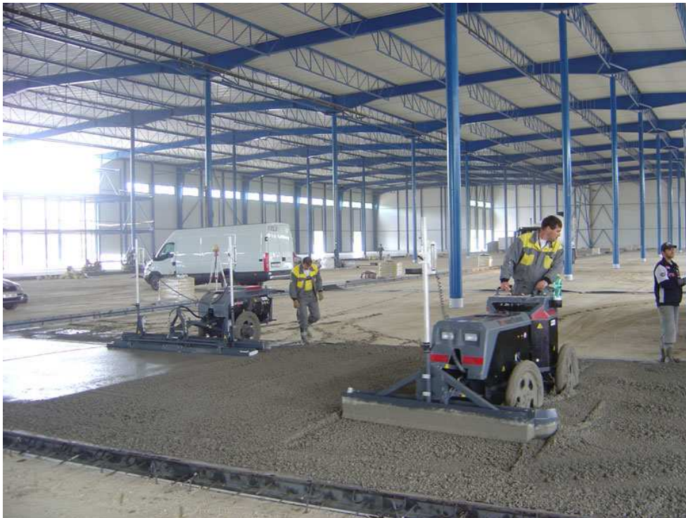
Obr. 7.6b. Hutnění a srovnávání betonu
