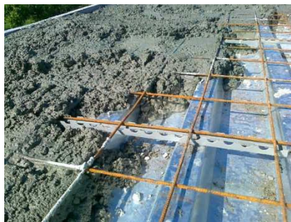
Obr. 7.5. Uložení kari sítě na dis. lištách
