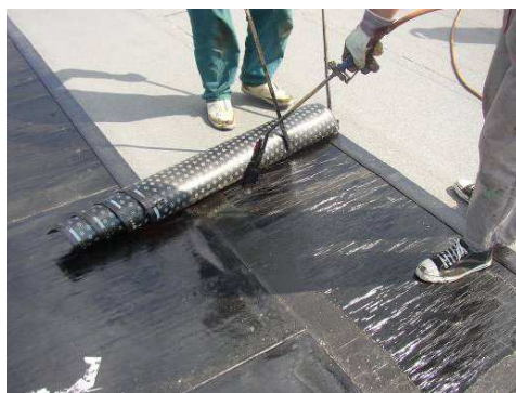
obr. 7.3a. Ukázka ukládání hydroizolačních pásů
