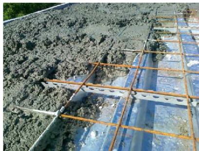
Obr. 7.5. Uložení kari sítě na dis. lištách
