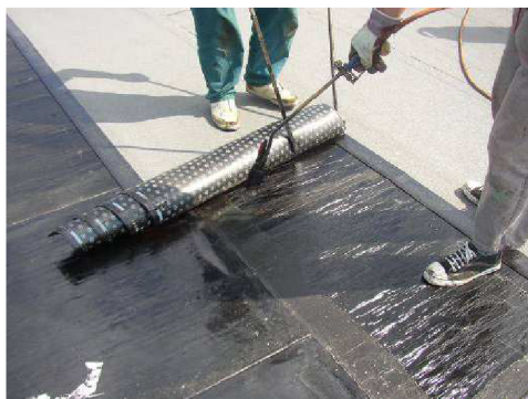
obr. 7.3a. Ukázka ukládání hydroizolačních pásů
