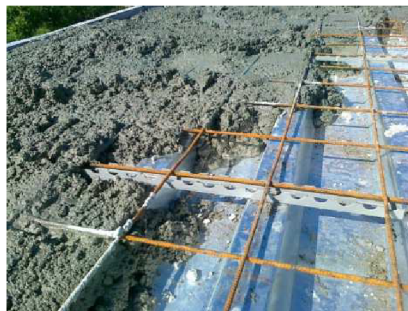
Obr. 7.1.9. Uložení kari sítě na dis. lištách
