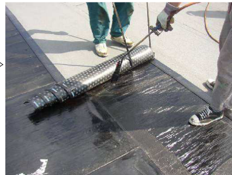
obr.7.1.3b. Natavování hydroizolačních pásů
