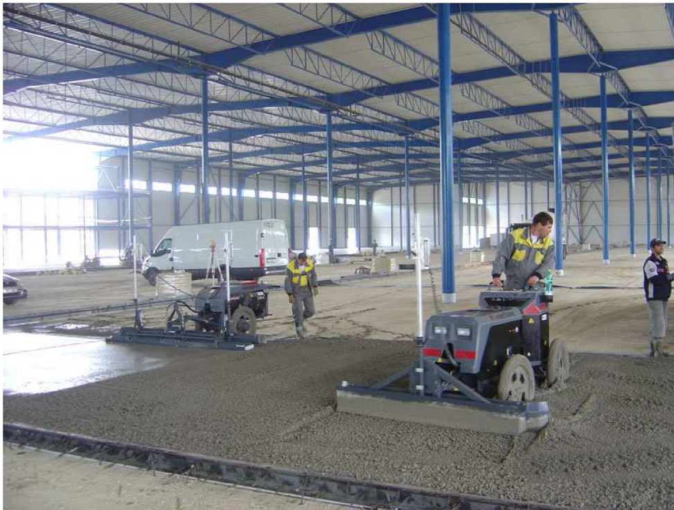
Obr. 7.6b. Hutnění a srovnávání betonu
