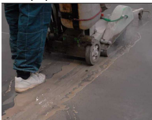
Obr. 7.6b. Prořezávání spár
