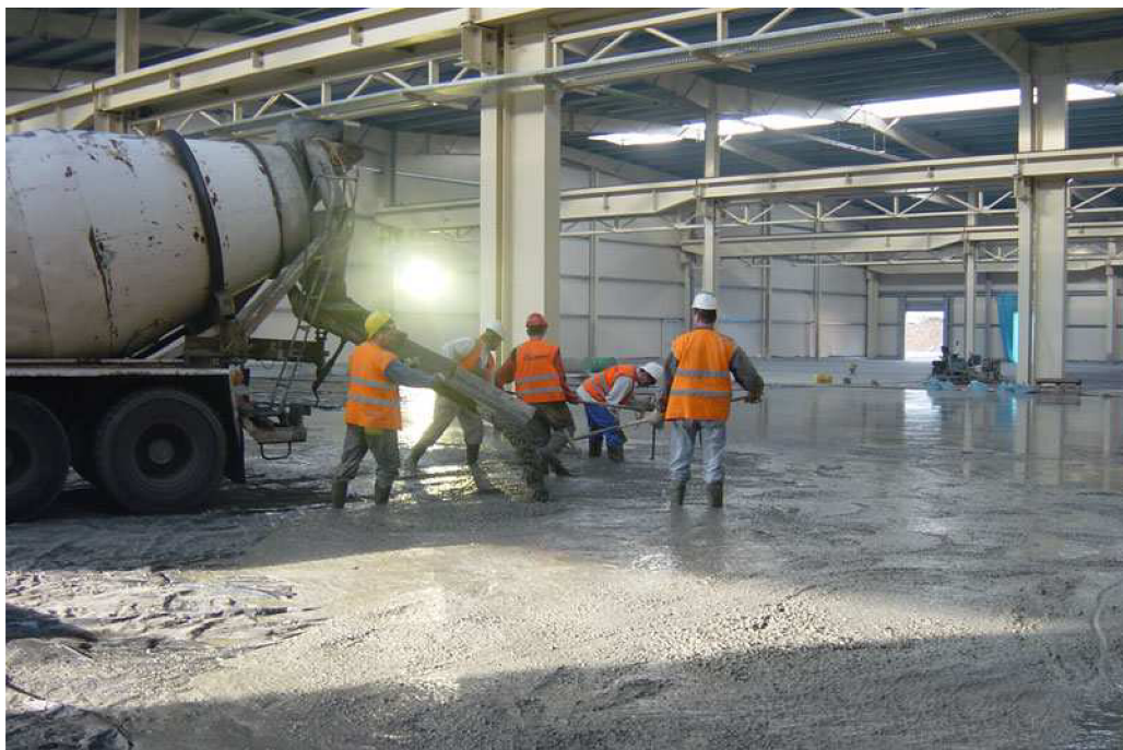
Obr. 7.6a. Ukládání betonu pomocí skluzu
