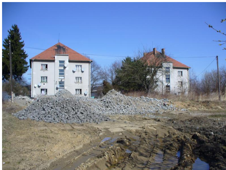
Obrázek č. 2: Azylový dům Strakonice a sousední dům s městskými byty
