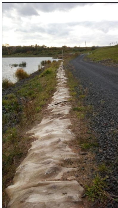
Obr. 16 - Odhalená geotextílie v severní části území
