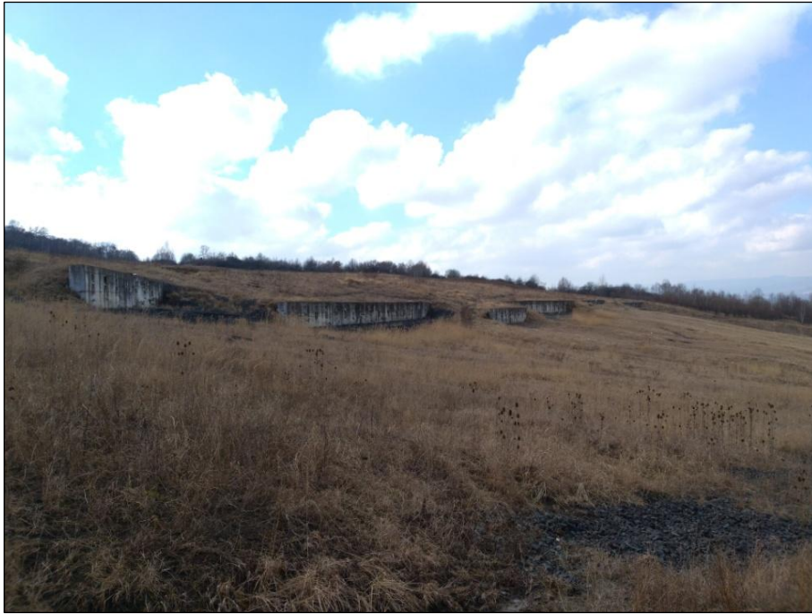
Obr. 11 – Opěrné zdi výsypky
