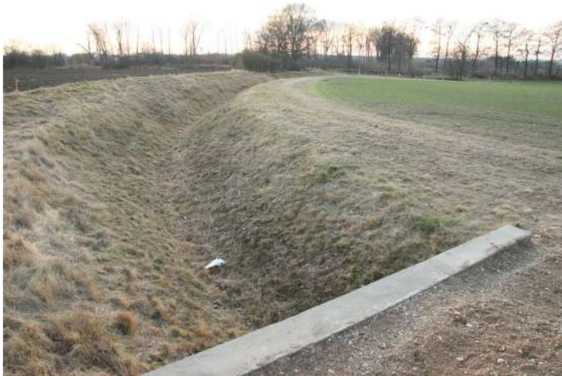
Obr. 11: Prodloužení začátku průlehu směrem k hranici k. ú. – suchému poldru (Autor: V. Prášek, 2011)
