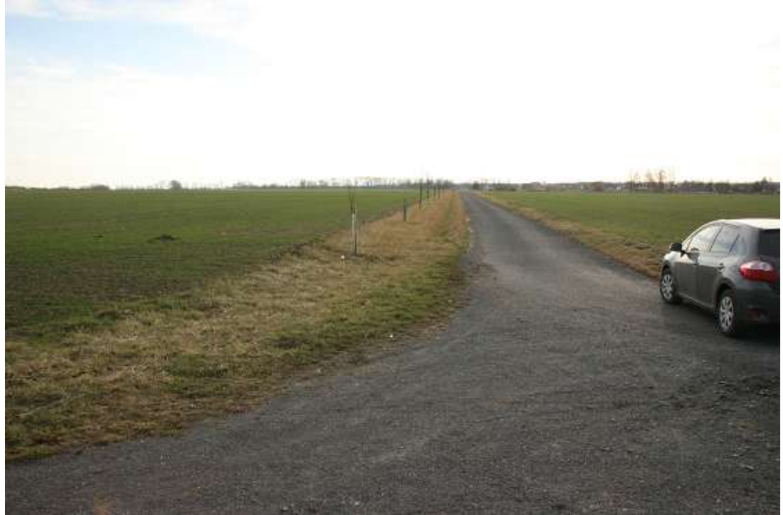
Obr. 2: Konec příkopu u C1 z cesty C11 (Autor: V. Prášek, 2011)
