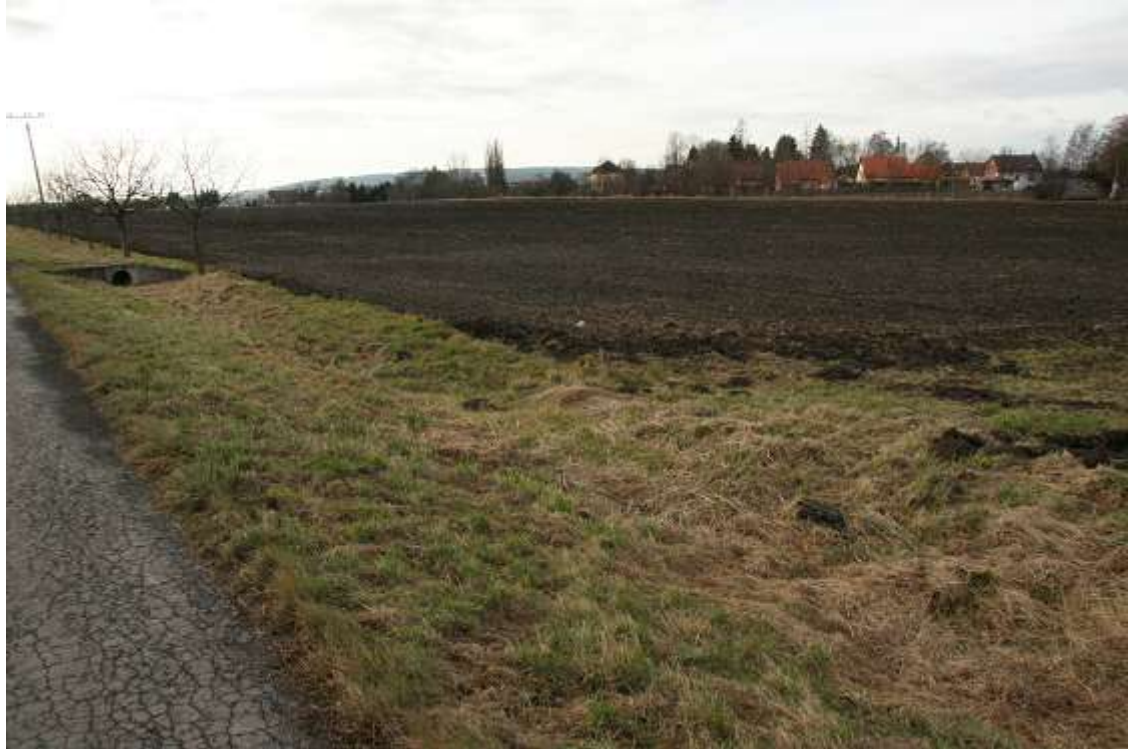
Obr. 5: Napojení průlehu SP3 do příkopu SP3 u silnice III/44815 + trubní propustek DN600 směrem od obce Vojnice k silnici II/448 (Autor: V. Prášek, 2011)
