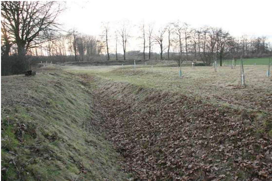
Obr. č. 10: Zaústění průlehu do suchého poldru (Majetín) – současný začátek průlehu u C13 (Autor: V. Prášek, 2011)
