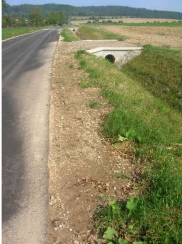
Obr. 7: Hospodářské sjezdy na cestu C2 přes ZP3 (Autor: Jan Zbirovský, 18.09.2009)
