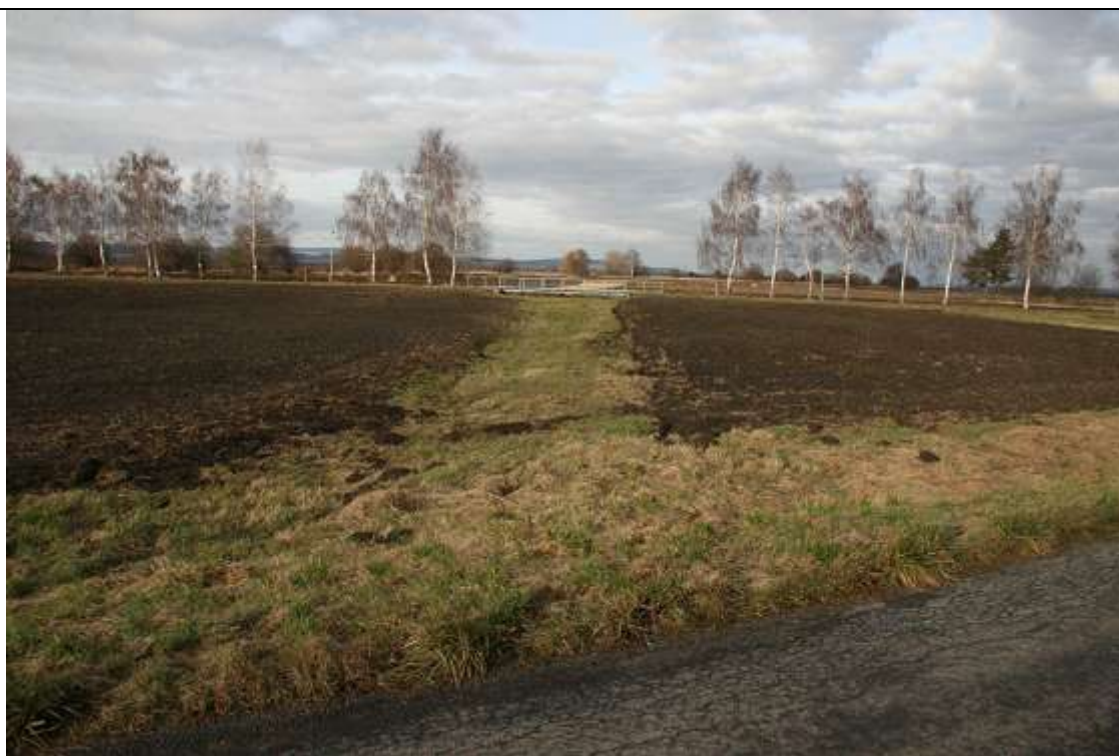
Obr. 4: SP3 s ocelovou lávkou s přelivem z Vojnické stružky k silnici III/44815 (Autor: V. Prášek, 2011)
