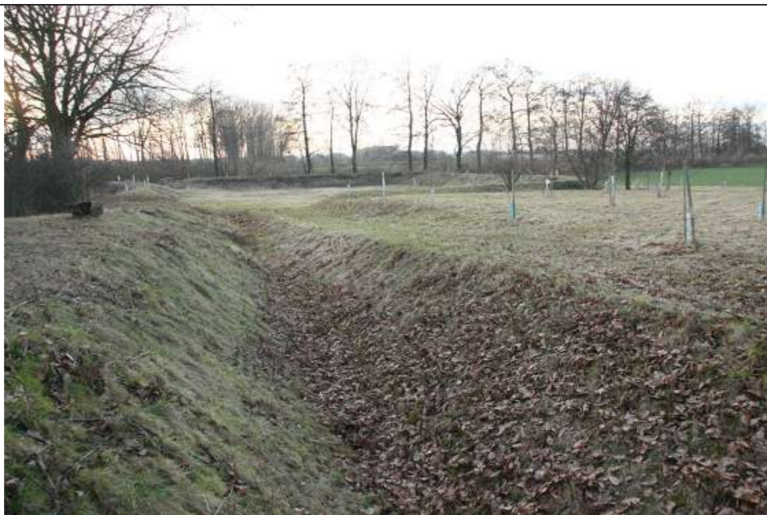
Obr. 12: Zaústění průlehu do suchého poldru – současný začátek průlehu (Autor: V. Prášek, 2011)
