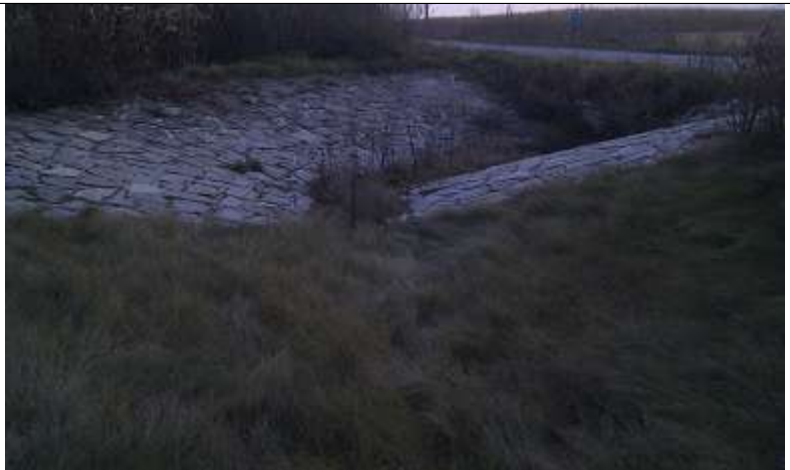
Obr. 6: Konec úseku SP1/2 – vstup trubního propustku pod silnicí III/48815 (Autor: V. Prášek, 2011)
