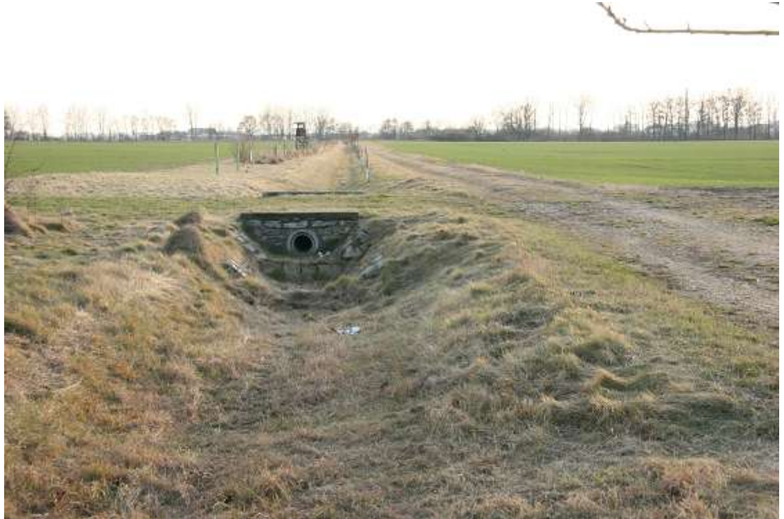
Obr. 7: Začátek průlehu u C12 s trubním propustkem pod cestou C5 (Autor: V. Prášek, 2011)
