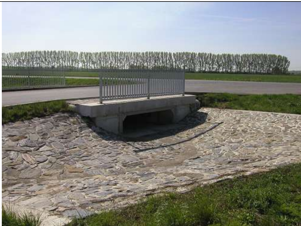
Obr. 6: Vpust' rámového mostu silnice III/44815( s pokračováním SP3 podél silnice II/448 k inundačnímu mostu) (Autor: Jan Zbirovský, 2003)
