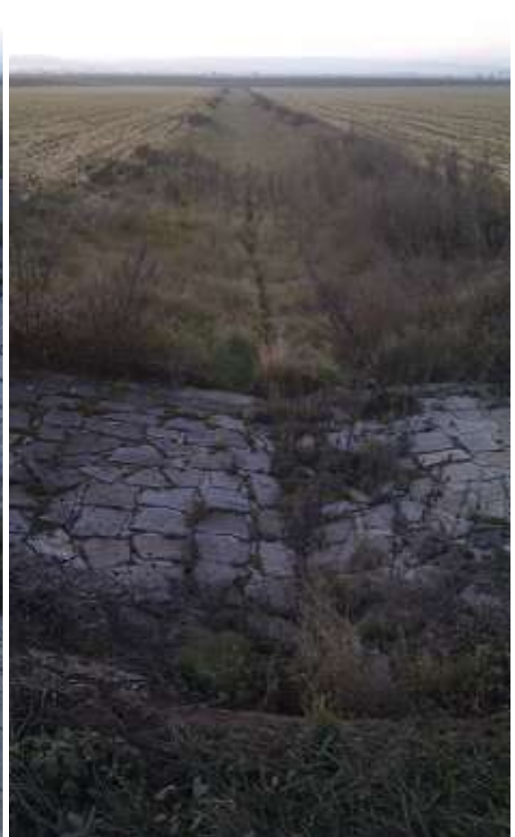
Obr. 8: Začátek SP1/3 z výpustě propustku pod silnicí III/48815 (Autor: V. Prášek, 2011)
