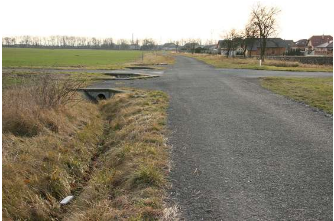
Obr. 3: Křížení příkopu u C1 s cestou C4 s trubním propustkem pod C4 a hospodářskými sjezdy č. 4 a 3 (Autor: V. Prášek, 2011)
