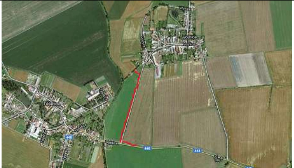
Obr. 1: Satelitní snímek obce Vojnice se svodným průlehem SP3 (Zdroj: http://maps.google.cz )
