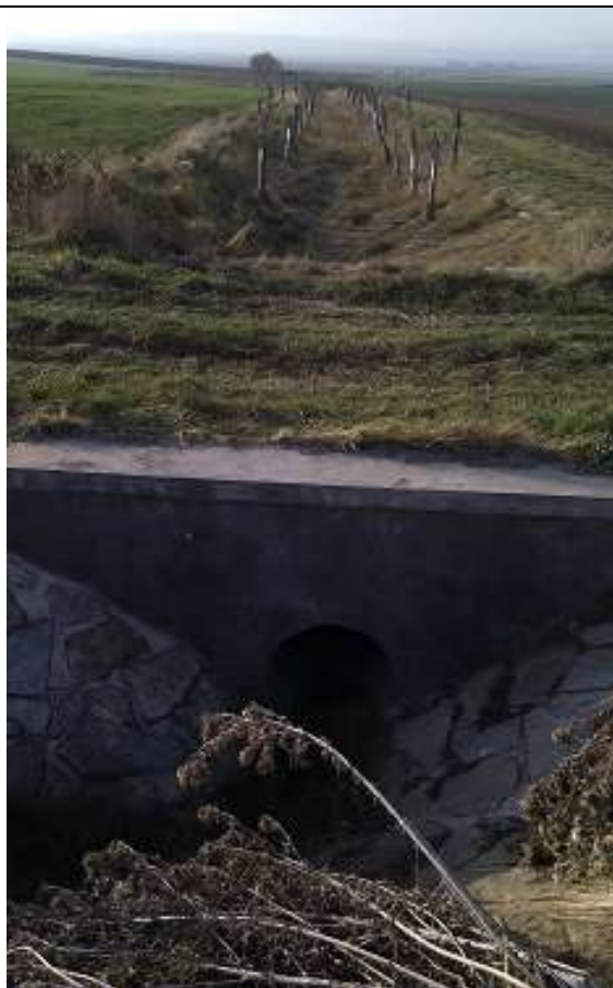
Obr. 3: Propustek pod C2/1 z průlehu SP-C162 do průlehu C16 P3/30, v pozadí BC17 (Autor: V. Prášek, 2011)
