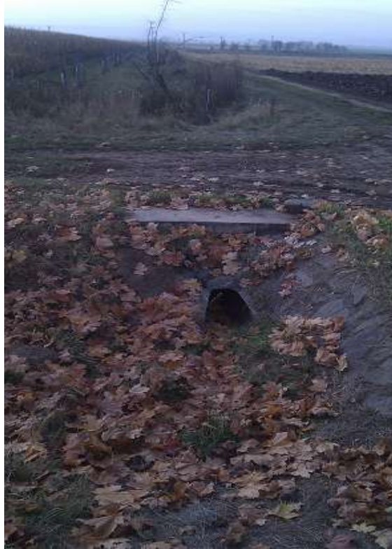
Obr. 2: Propustek pod cestou u ZP161/1 do SP1/1 (pohled od C16 BK18) (Autor: V. Prášek, 2011)
