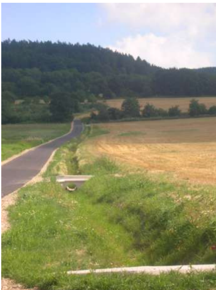
Obr. č. 42: Pohled na konec ZP3 (Plinkout) s výjezdem na pozemek č. 993/49 ze dne 07.08.2009 (Autor: J. Zbirovský)
