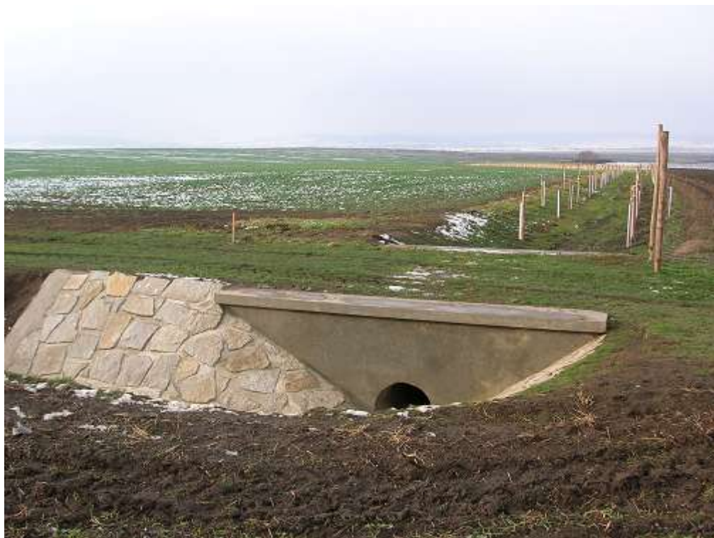
Obr. 2: Propustek pod C2/1 z průlehu SP-C162 do průlehu C16 P3/30, v pozadí BC17 (Autor: Jan Zbirovský, 2007)
