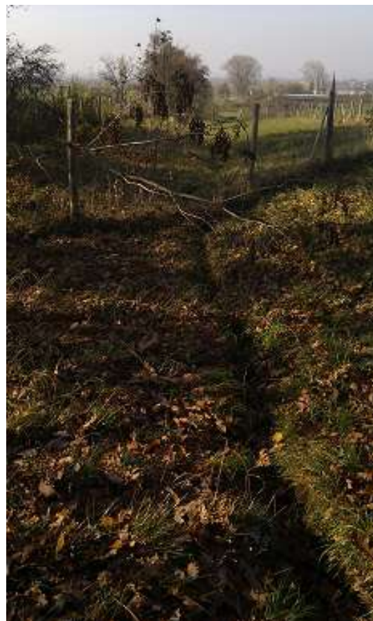
Obr. č. 39: SP3 (Dolní Dlouhá Loučka) od zlomu průlehu do jeho začátku - dno narušené erozní rýhou (Autor: V. Prášek, 2011)
