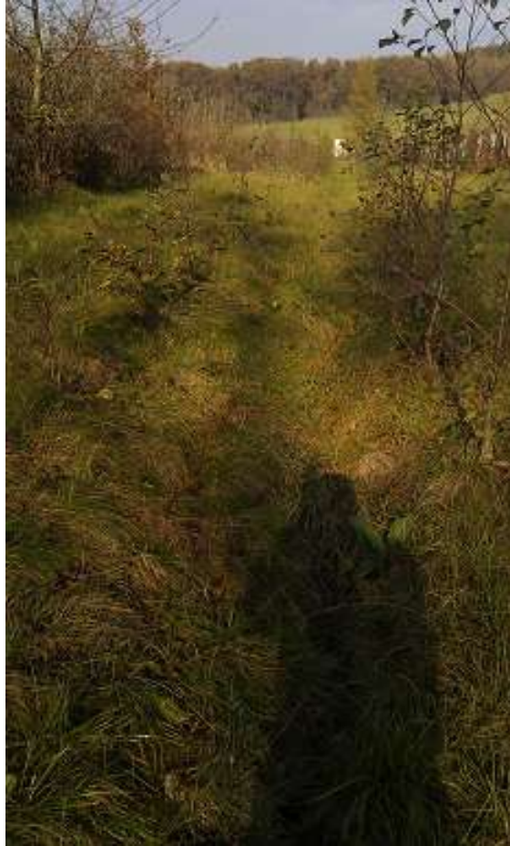
Obr. 5: SP3 od zlomu průlehu do jeho konce – dno výrazně zanesené usazenou zeminou (Autor: V. Prášek, 2011)
