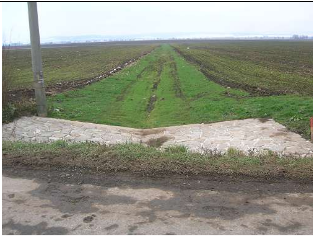
Obr. 9: Začátek SP1/3 z výpustě propustku pod silnicí III/48815 (Autor: Jan Zbirovský, 2007)
