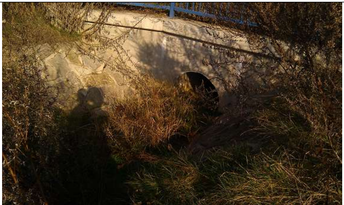
Obr. 4: Výpusť trubního propustku pod silnicí III/4451 (Autor: V. Prášek, 2011)
