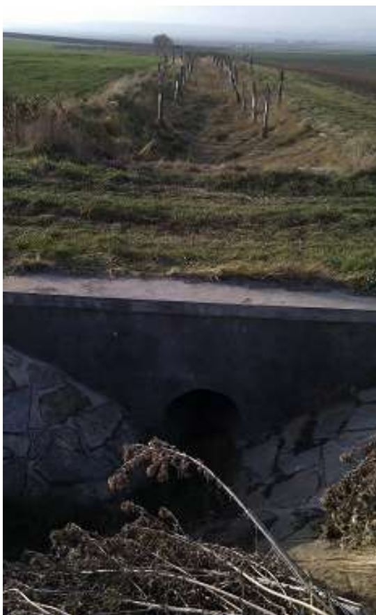
Obr. č. 21: Propustek pod C2/1 (Vojnice) z průlehu SP-C162 do průlehu C16 P3/30, v pozadí BC17 (Autor: V. Prášek, 2011)
