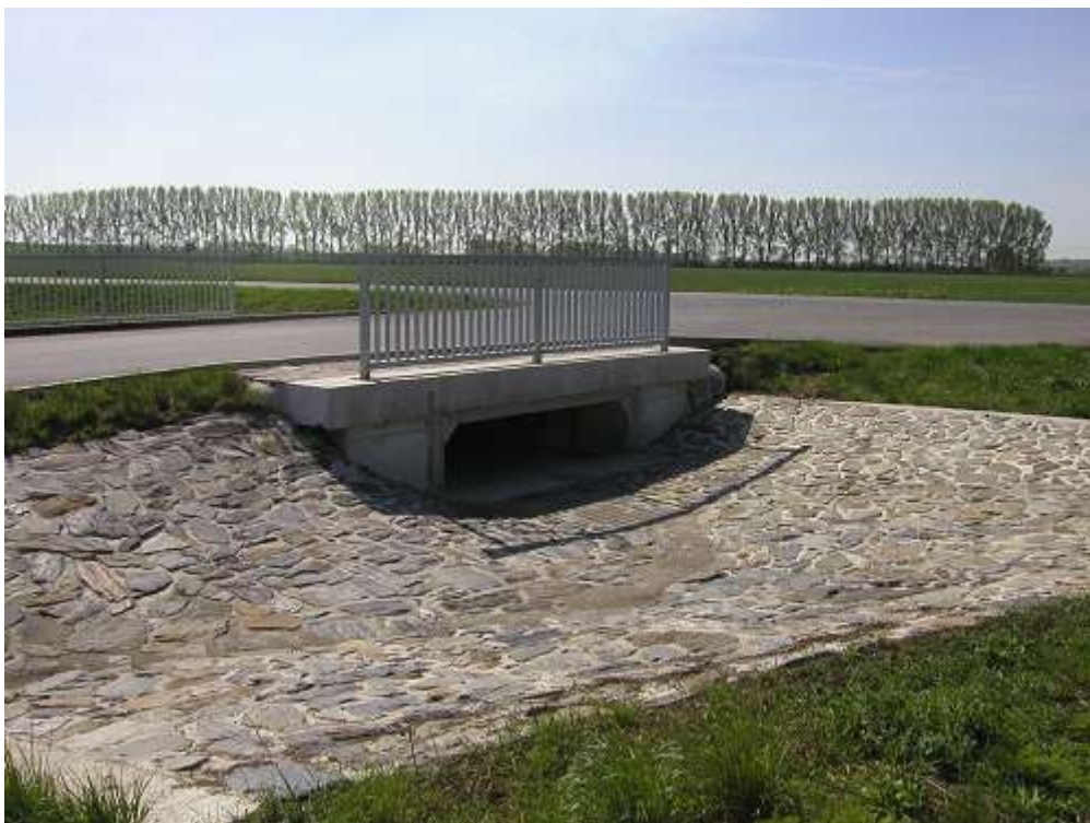
Obr. č. 32: Vpust' rámového mostu silnice III/44815, s pokračováním SP3 (Vojnice) podél silnice II/448 k inundačnímu mostu (Autor: J. Zbirovský, 2003)
