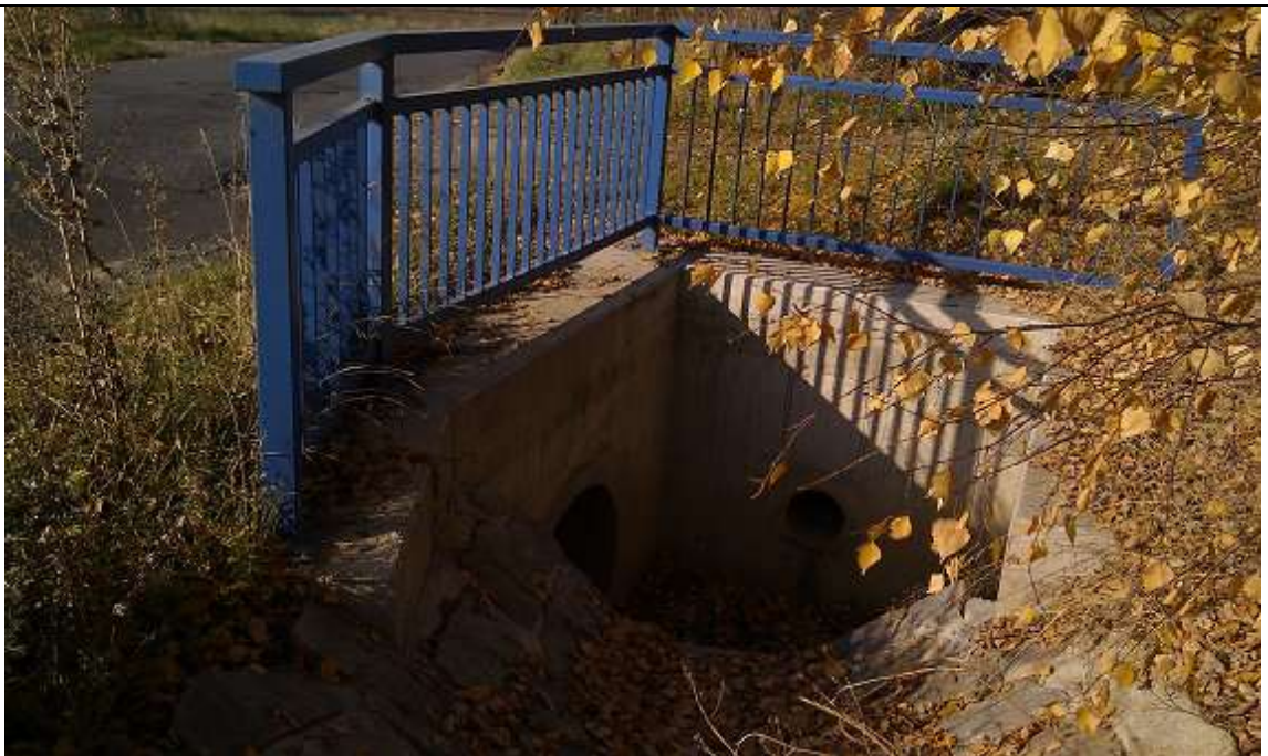
Obr. 2: Vpust' trubního propustku (vlevo) pod silnicí III/4451 z příkopu této silnice (Autor: V. Prášek, 2011)
