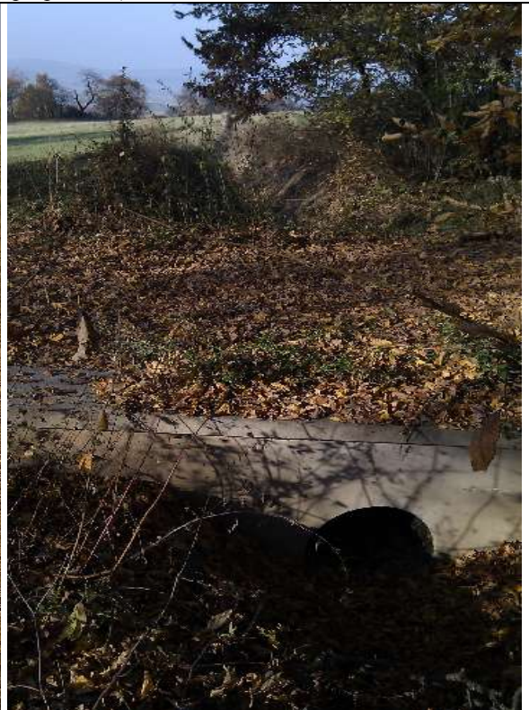
Obr. 12: Vpusť posledního 5. trubního propustku (Autor: Václav Prášek)
