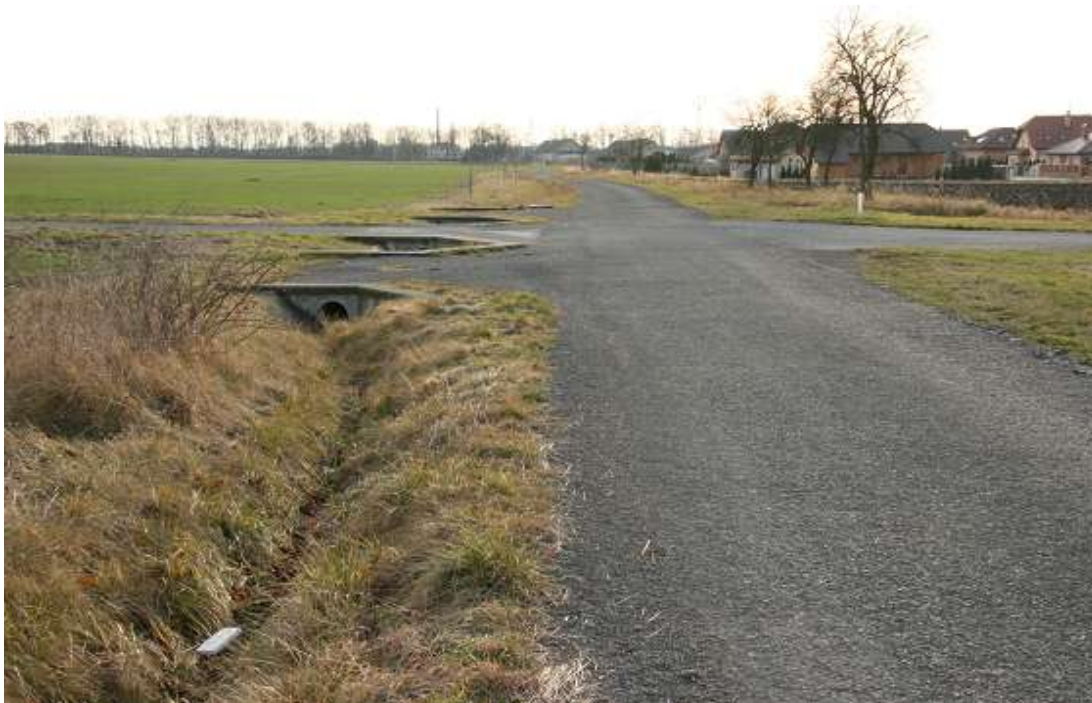
Obr. č. 6: Křížení příkopu u cesty C1 (Majetín) s cestou C4 s trubním propustkem pod C4 a hospodářskými sjezdy č. 4 a 3 (Autor: V. Prášek, 2011)
