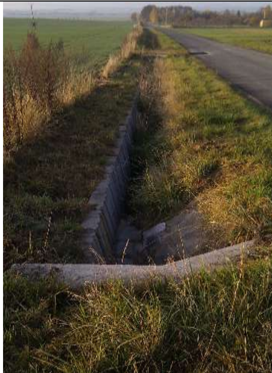
Obr. 10: Zpevnění břehu mezi 7. a 8. přejezdem (Autor: Václav Prášek)
