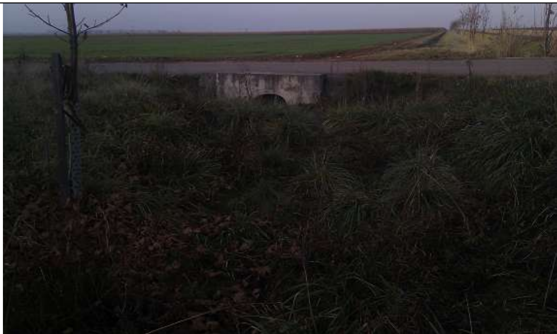
Obr. 7: Začátek ZP161/2 s propustkem pod cestou B2 (Autor: V. Prášek, 2011)
