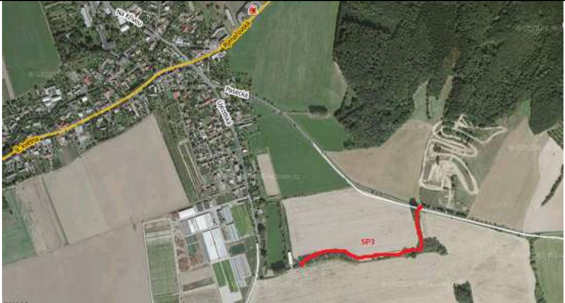
Obr. 1: Satelitní snímek obce Dlouhá Loučka s vyznačeným průlehem SP3 (Zdroj: http://maps.google.cz )
