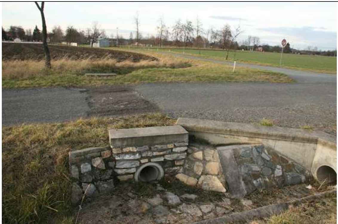
Obr. 4: Detail trubního propustku pod C1 realizované obcí Majetín po ukončení KPU s příkopem podél cesty C4 s napojením na rybník Hliník (Autor: V. Prášek, 2011)
