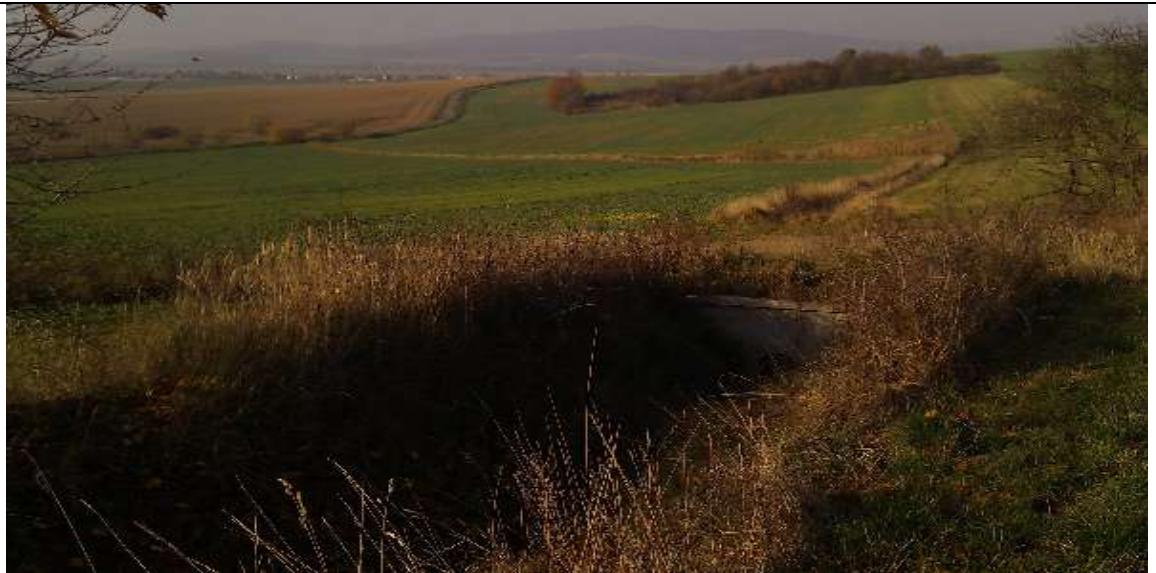
Obr. 8: Pohled na 2.propustek a 1. třetinu ZP5 směrem k silnici III/4491 (Autor: Václav Prášek)
