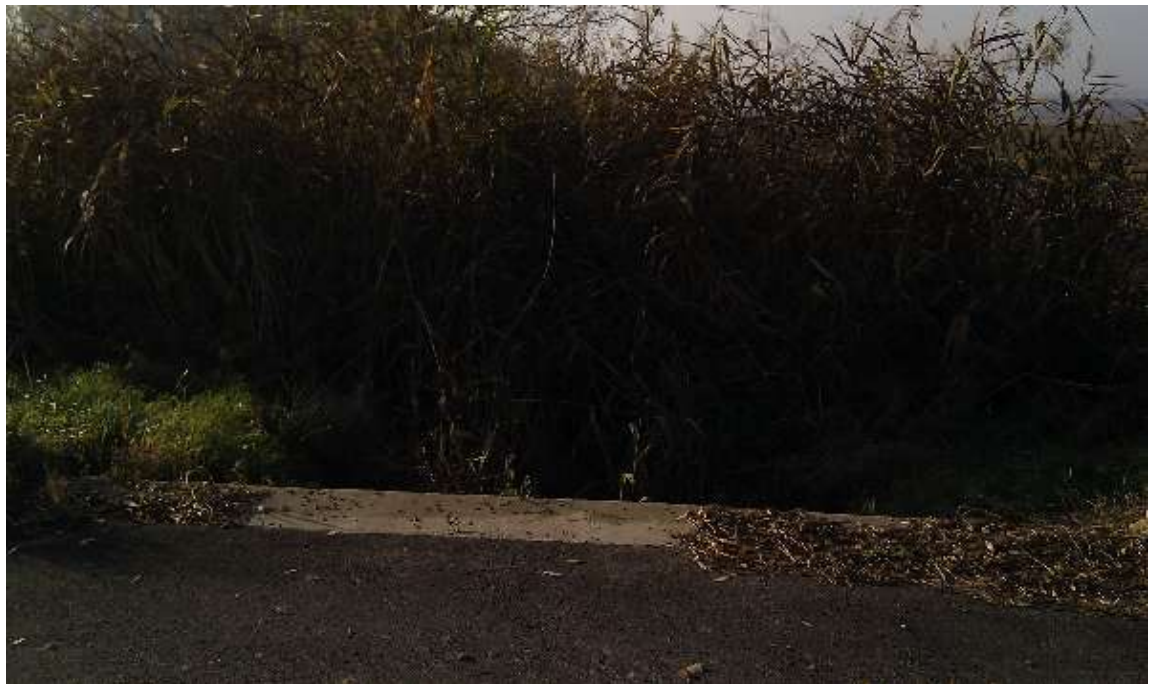
Obr. 2: Začátek příkopu z 1.trubního propustku silnice III/4491 z 09.11.2011 (Autor: Václav Prášek)
