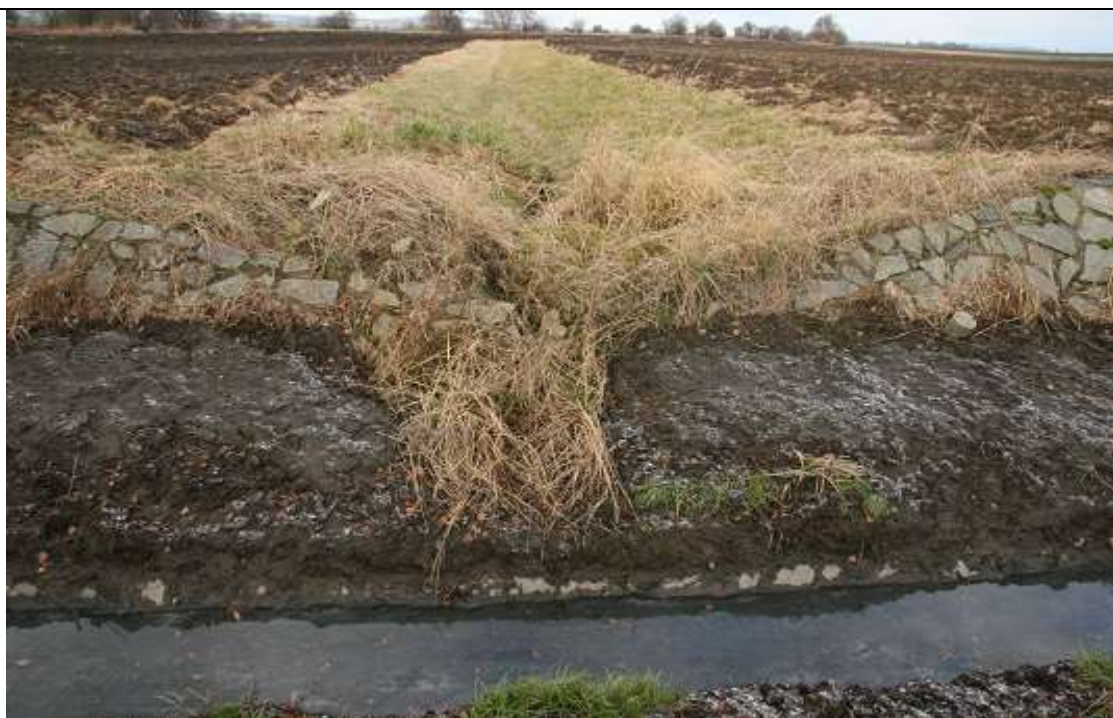
Obr. 11: Pohled na začátek SP2 a Vojnickou stružku z ocelové lávky (Autor: V. Prášek, 2011)
