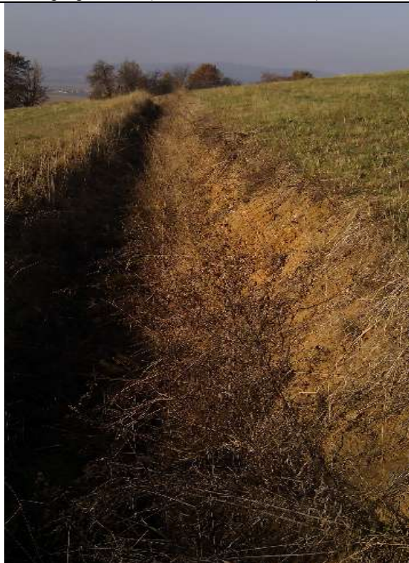
Obr. 11: Pohled na erodovaný svah příkopu z pohledu od konce příkopu (Autor: Václav Prášek)
