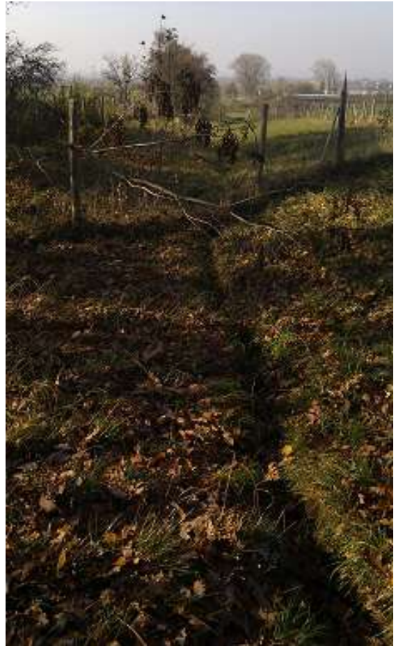
Obr. 6: SP3 od zlomu průlehu do jeho začátku - dno narušené erozní rýhou (Autor: V. Prášek, 2011)
