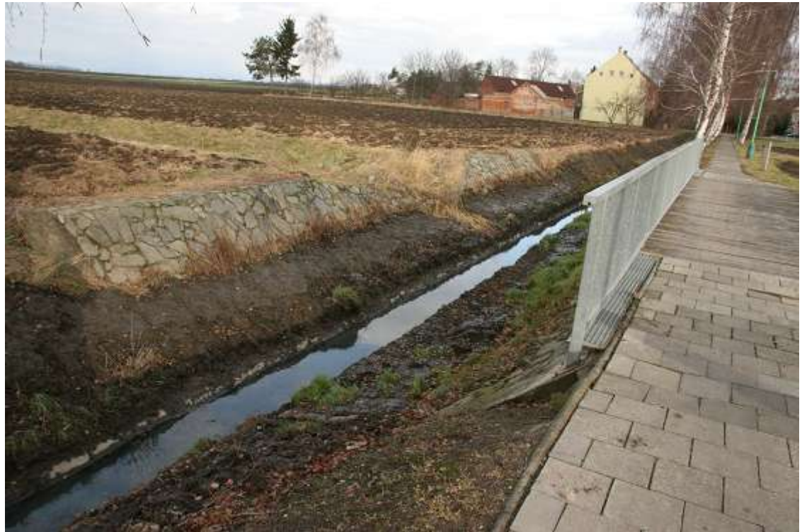
Obr. 12: Pohled na zaústění SP2 do Vojnické stružky a ocelovou lávku (Autor: V. Prášek, 2011)
