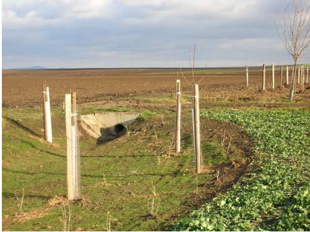
Obr. 2: Trubní propustek z průlehu ZP161/1 (vpravo) a BK18 s cestou C16 bez příkopu (za trubním propustkem) (Autor: Jan Zbirovský, 2007)
