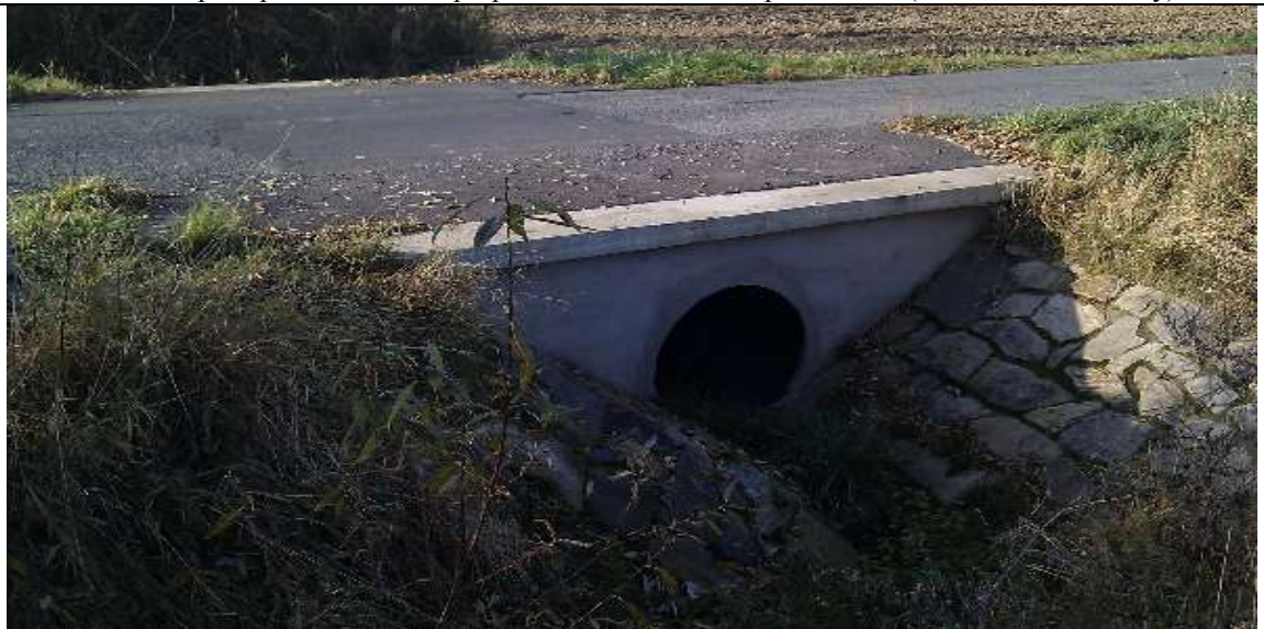
Obr. 4: První trubní propustek DN1000 pod silnicí III/4491 (Autor: Václav Prášek)
