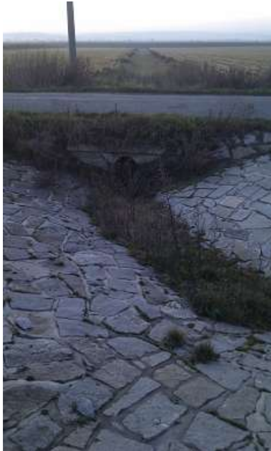
Obr. 7: Detail vpustě propustku pod silnicí III_48815 (Autor: V. Prášek, 2011)
