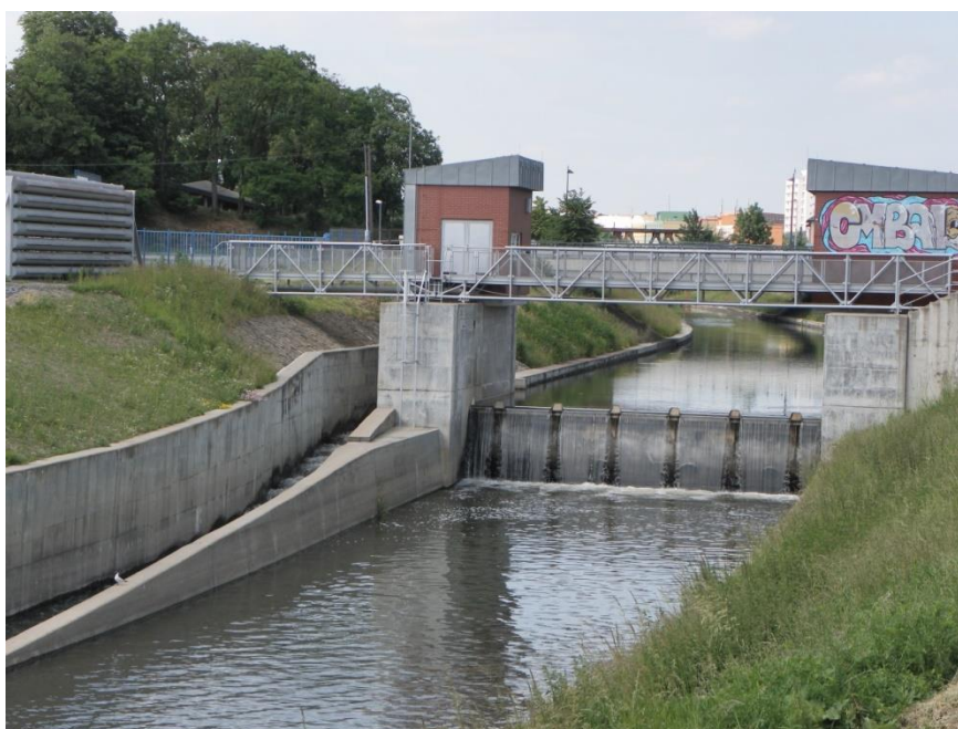
Obr. 17: Jezový objekt u plynárny s rybím přechodem. Zdroj: (vlastní)
