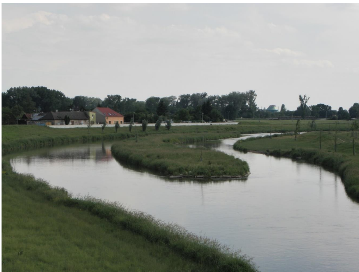
Obr. 22: Nově vzniklé paralelní koryto se zeleným ostrovem. Zdroj: (vlastní)
