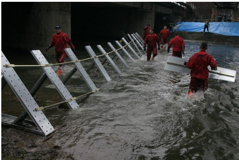
Obr. 14: Ukázka stavby Aqua Barrier jednotkami SDH, Zdroj: (Odbor ochrany, 2012)
