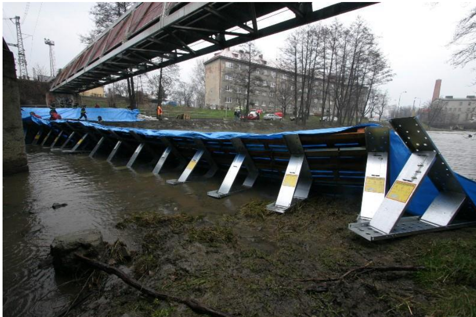
Obr. 15: Názorná ukázka stavby Aqua Barrier jednotkami SDH, Zdroj: (Odbor ochrany, 2012)
