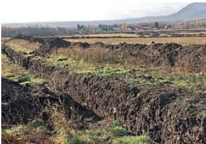
Obrázek č. 13, Výstavba infrastruktury budoucího stavebního souboru „Nové Záluží“ na vnitřní výsypce lomu Rudý sever (foto z r. 2010), zdroj: www.litvinov.sator.eu
