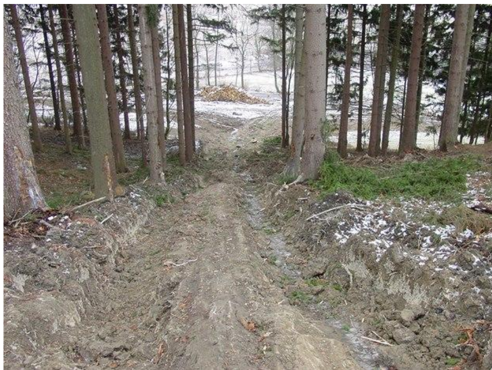
Obr.č. 5: Poškození cesty vlivem těžby (Petr Kuna, SCHKO Broumovsko)
