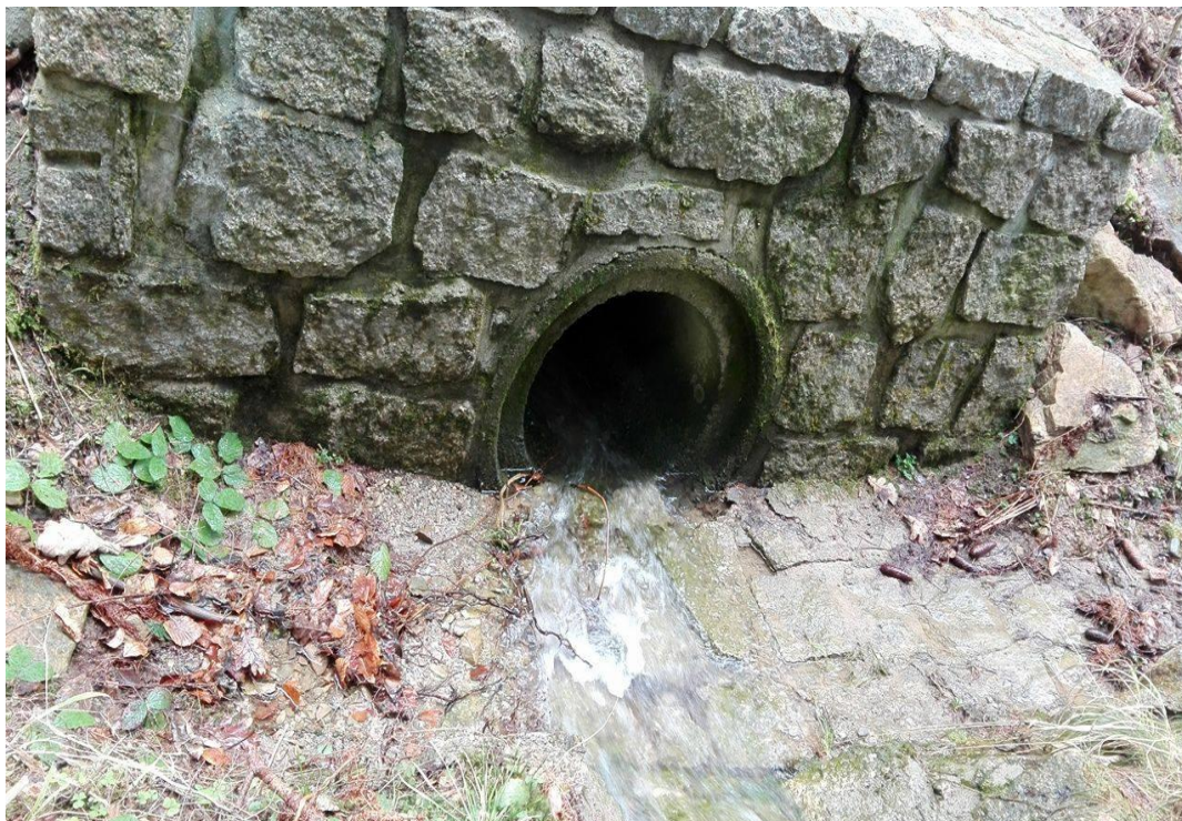
Obr. č. 6: Trubní propustek (Částková, 2017)
