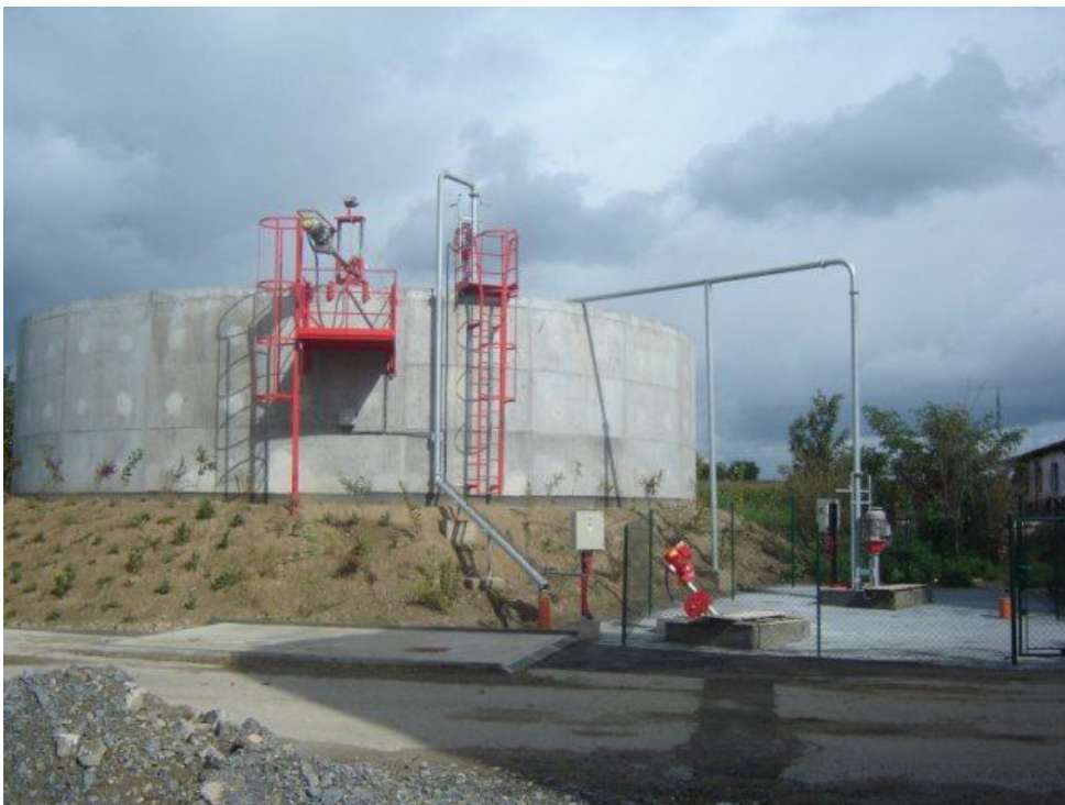
Fotografie 7-4 Přečerpávající jímka na uskladnění kejdy; zdroj: Vyšší odborná škola a Střední zemědělská škola, Tábor
