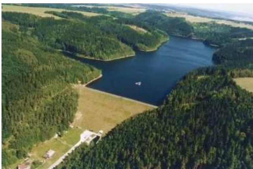
Obr. 2 - Vodní nádrž Horka – letecký snímek 7
