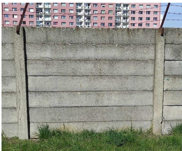
Obrázek 51: Stávající betonové oplocení
