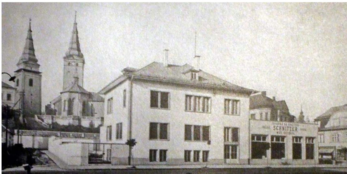
Príloha č. 4 – domy pod balustrádami zbúrané na začiatku 40. rokov.
