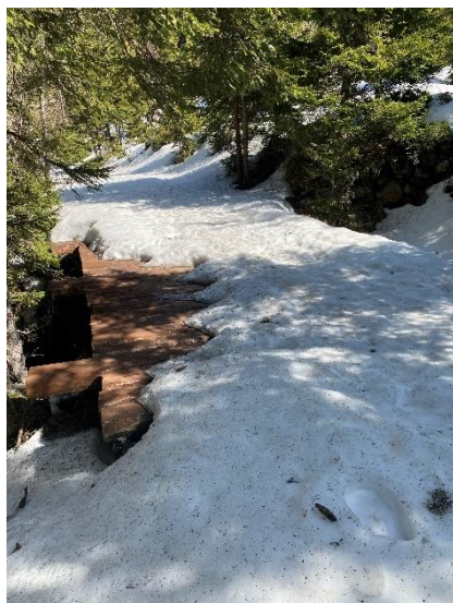
Obrázek 21 Dřevěný mostek přes řeku, v dobrém stavu
