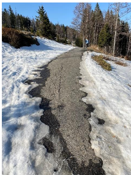
Obrázek 33 Asfaltová cesta na Javoří
