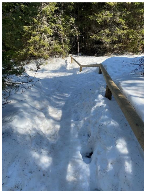
Obrázek 18 Zábradlí od jezera, kvalitní
