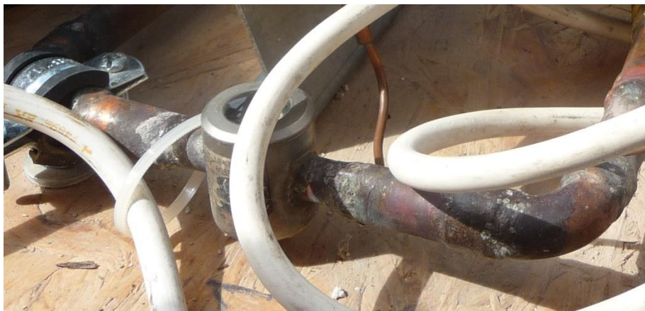
Obrázek č. 25 Průhledítko na sací straně (foto: Oliva)
