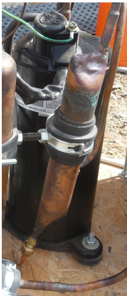
Obrázek č. 26 Odlučovač oleje (foto: Oliva)
