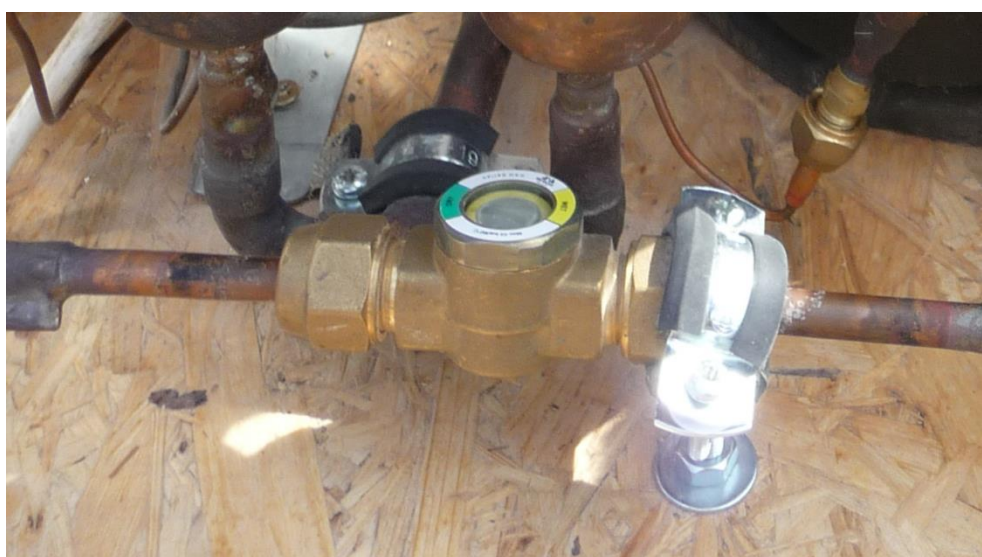
Obrázek č. 29 Průhledítko na výtlačné straně kompresoru (foto: Oliva)
