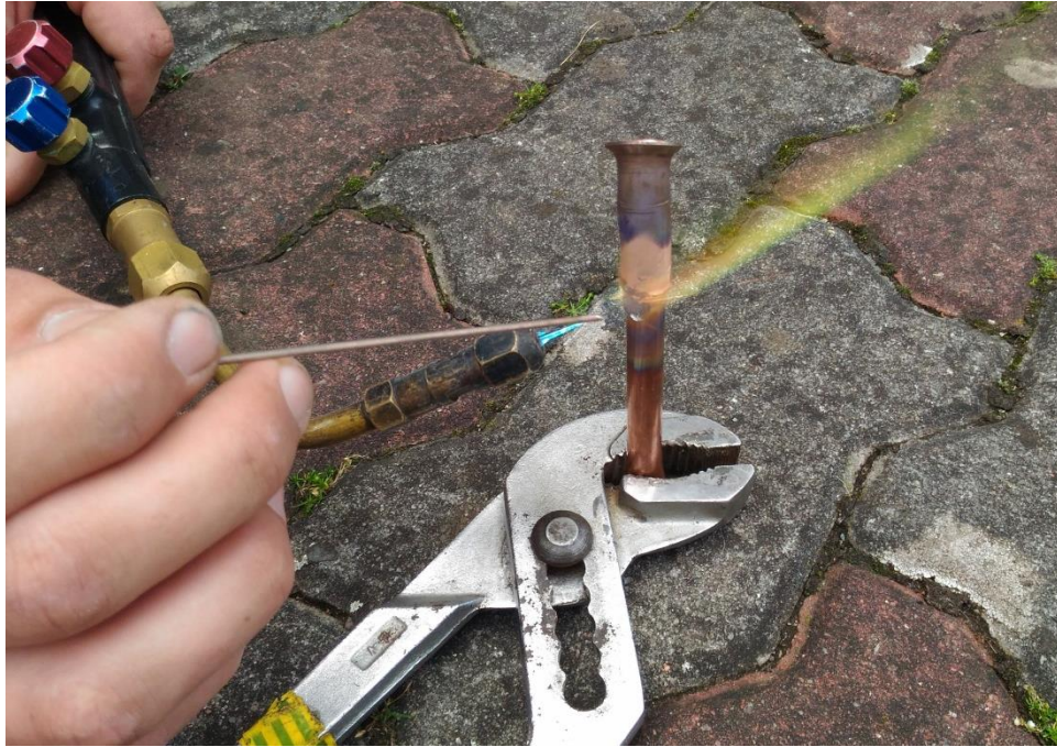
Obrázek č. 42 Ukázka pájení měděných komponentů (foto: Oliva)
