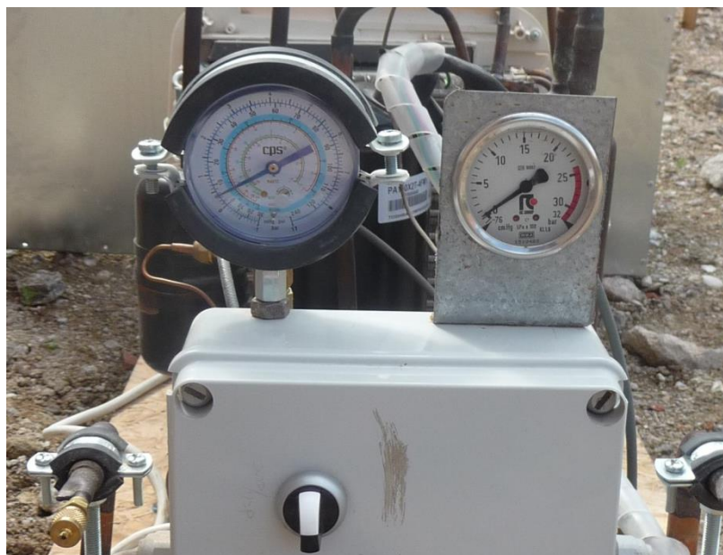
Obrázek č. 34 Umístění manometru nízkého a vysokého tlaku (foto: Oliva)
