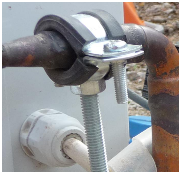
Obrázek č. 31 Uchycení potrubí pomocí topenářských úchytek (foto: Oliva)
