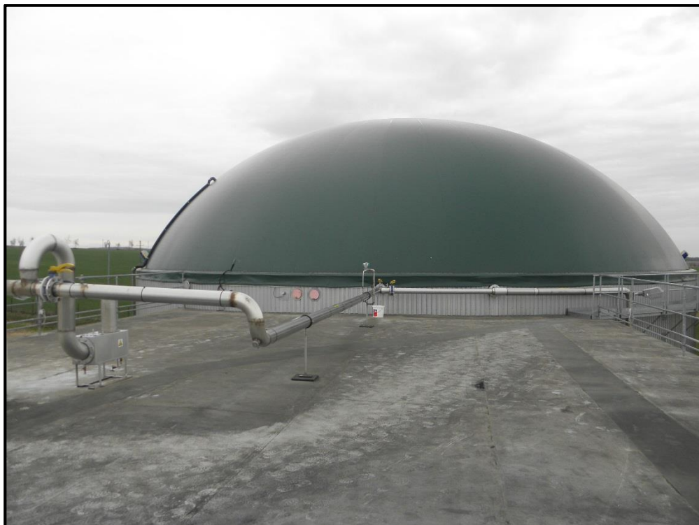
Obr. č. 24 – Dofermentor s integrovaným plynojemem (zdroj: Lucie Frank Kristová 29. 3. 2016)
