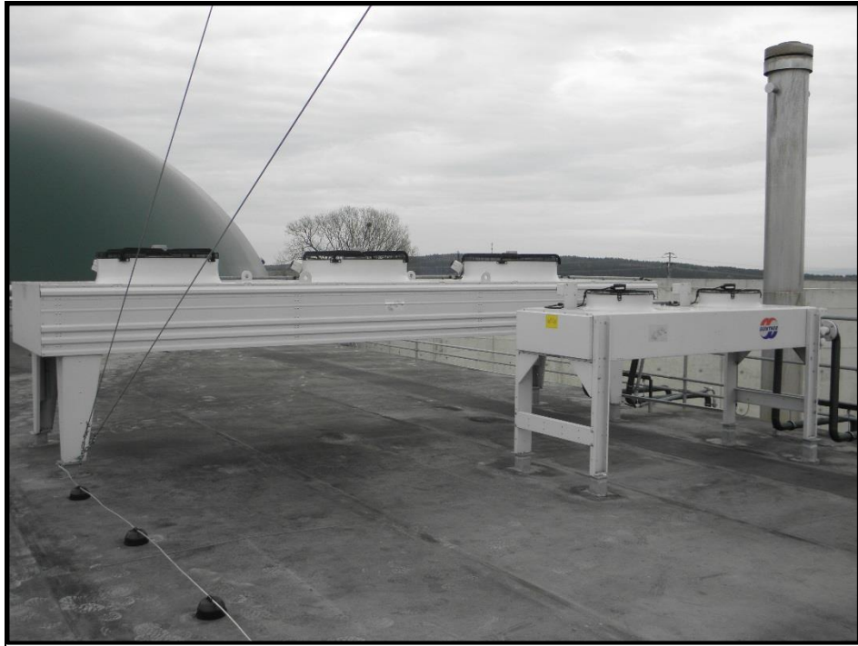
Obr. č. 25 – Externí chladič motoru a bioplynu (zdroj: Lucie Frank Kristová 29. 3. 2016)
