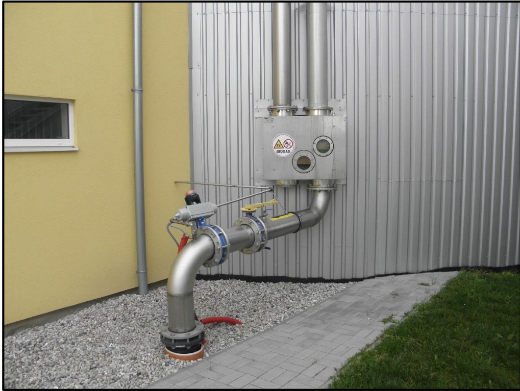
Obr. č. 27 – Podtlaková a přetlaková pojistka plynu a hlavní uzávěr bioplynu (zdroj: Lucie Frank Kristová 29. 3. 2016)
