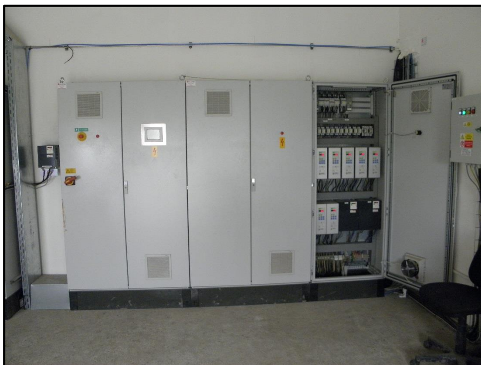
Obr. č. 32 – Pojistkové skříně BPS (zdroj: Lucie Frank Kristová 29. 3. 2016)
