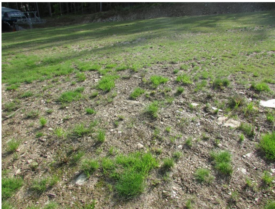
Obr. 1 Špatně založený vegetační pokryv po 7 letech od založení. Velké kameny značí nedodržení podmínky nepřevrstvování půdních horizontů. Lokalita Hoffmanovi boudy, Janské Lázně.
