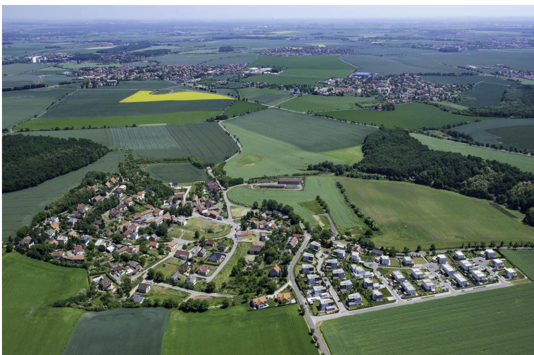
Obrázek 11: Letecký snímek v obci Sedlec, okres Praha – východ, výstavba nových obytných domů tzv. „satelitních měst“ (Kuklík ex obec Sedlec ©2016).
