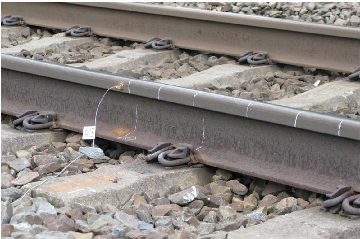
Obr. A.6 Zkouška TDR - umístění snímače zrychlení pro příčný směr
