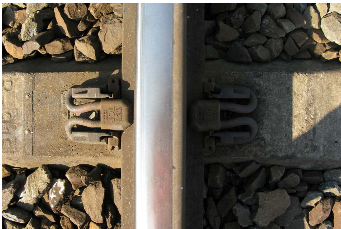
Obr. A.4 Upevnění Pandrol FC I; měřicí úsek Napajedla
