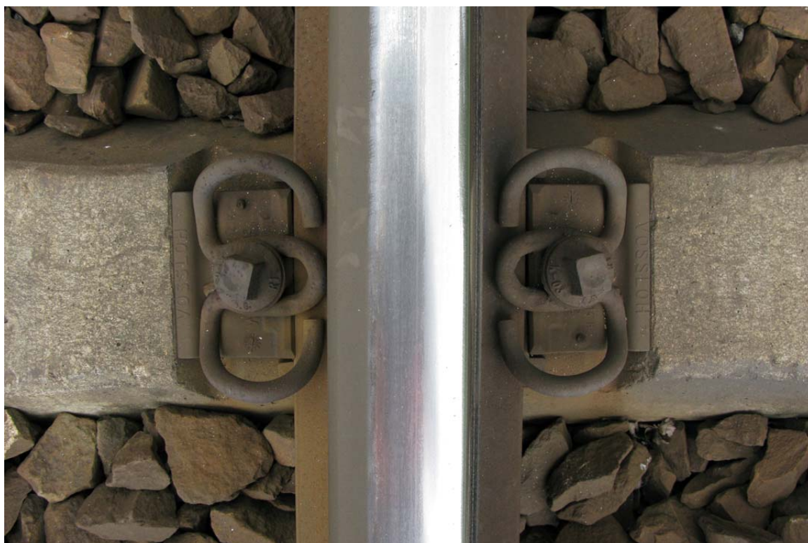
Obr. A.3 Upevnění Vossloh W14; měřicí úsek Hranice na Moravě
