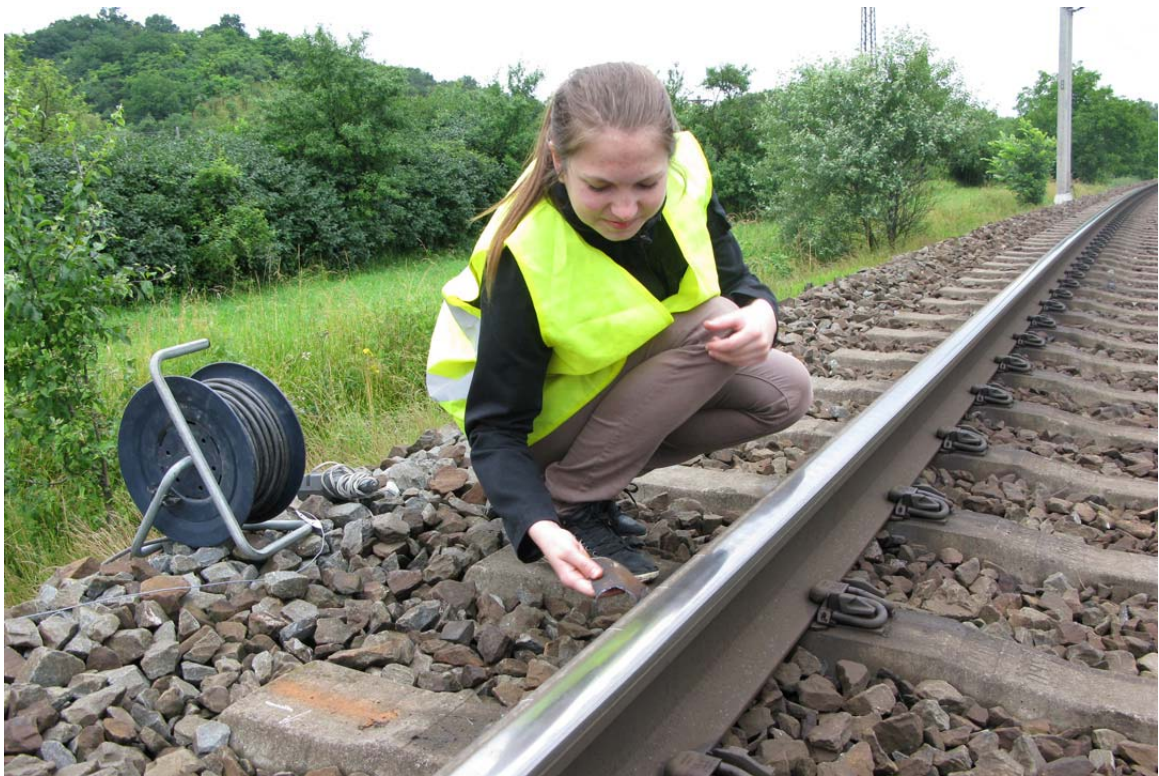
Obr. A.5 Příprava před zkouškou TDR - úprava povrchu kolejnice smirkovým papírem
