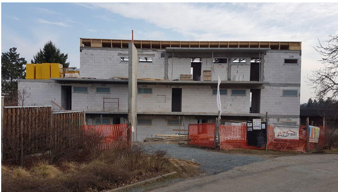
Obrázok 2 - Výstavba Centra pro transfer technológií
