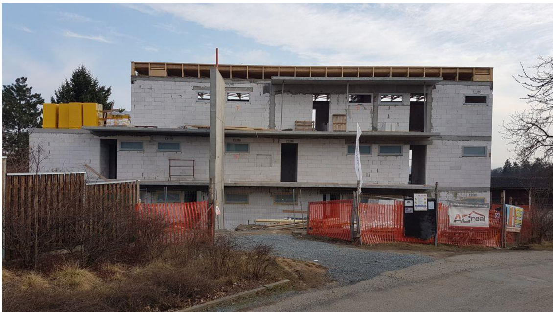
Obrázok 2 - Výstavba Centra pro transfer technológií
