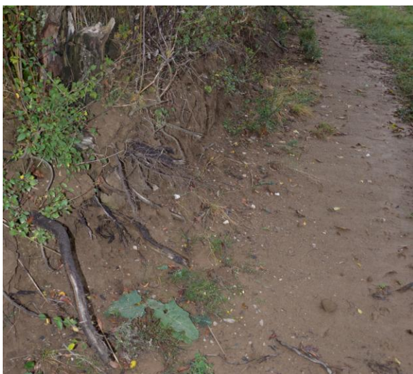
Obrázek 4.16: Poškození kořenového systému (vlastní)
