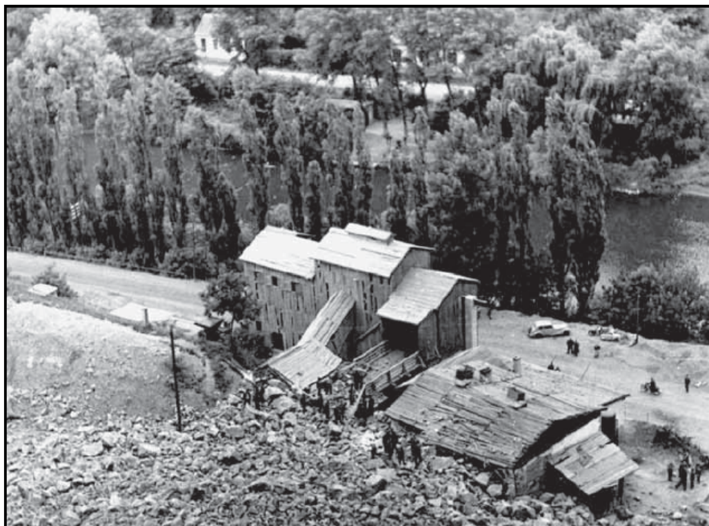
Obrázek č. 9 Pohled na budovy lomu, rok 1968 [7]
