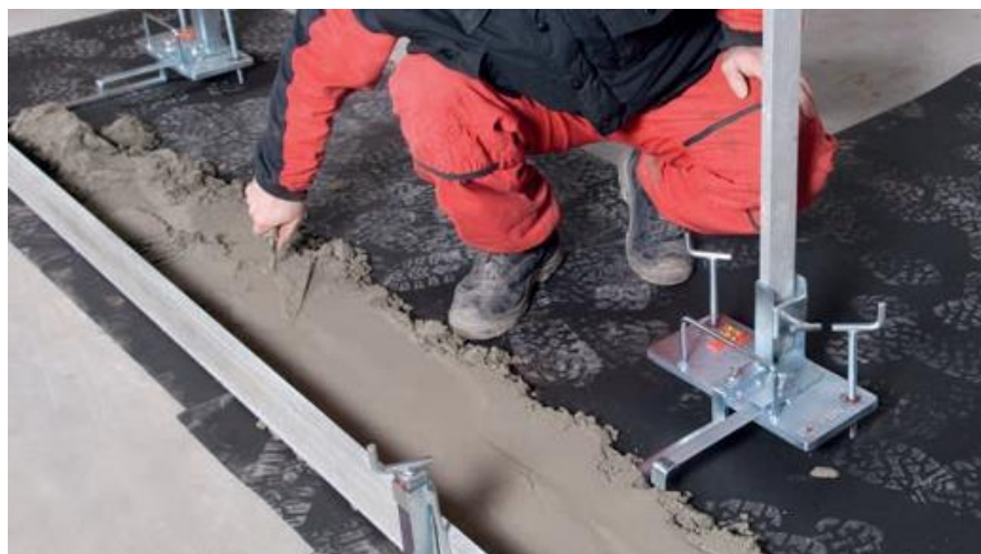
Obrázek 14 - nanášení základací vrstvy (4)
