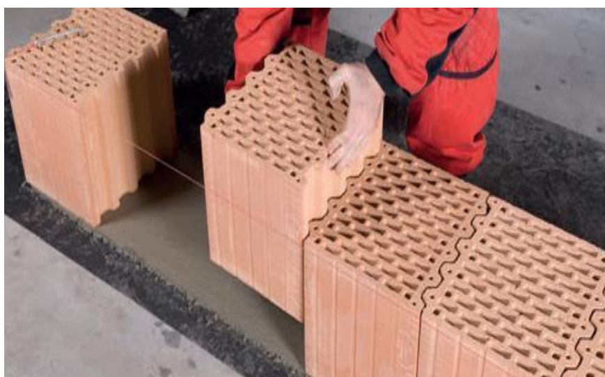
Obrázek 13 - založená první řady zdiva (4)
