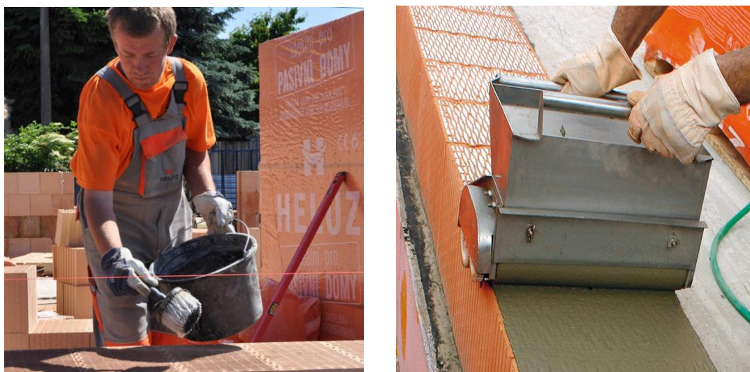
Obrázek 15 - vlhčení zdiva a dávkování malty (4)
