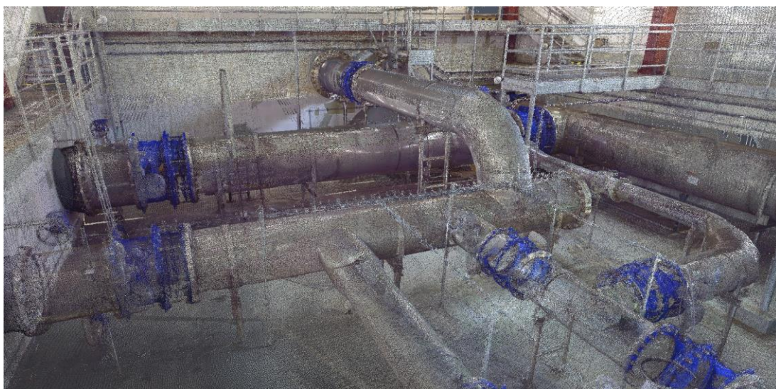
Obr. 16 Naskenované mračno bodov armatúrnej komory
