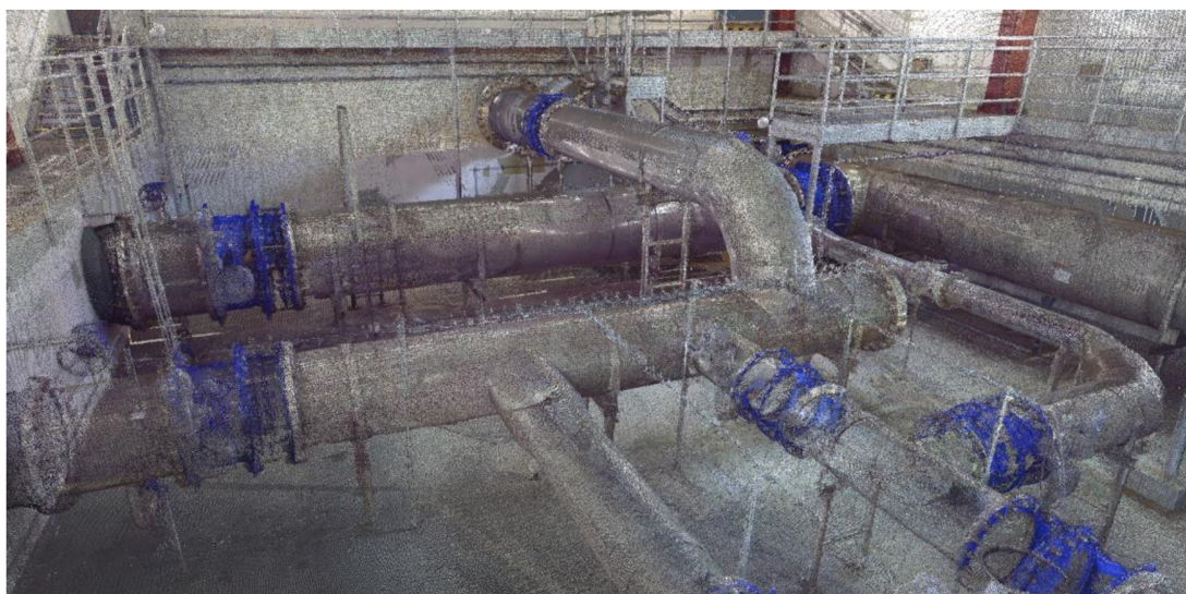
Obr. 16 Naskenované mračno bodov armatúrnej komory
